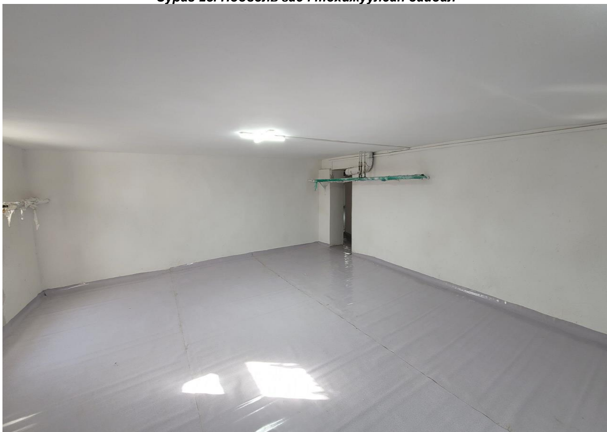
Зураг 24. Подволь засч тохижуулсан байдал
