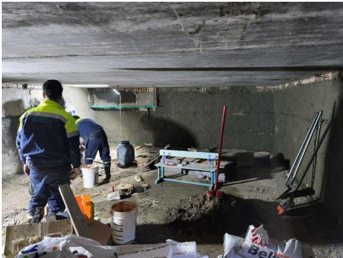
Зураг 23. Подволь засч тохижуулсан байдал
