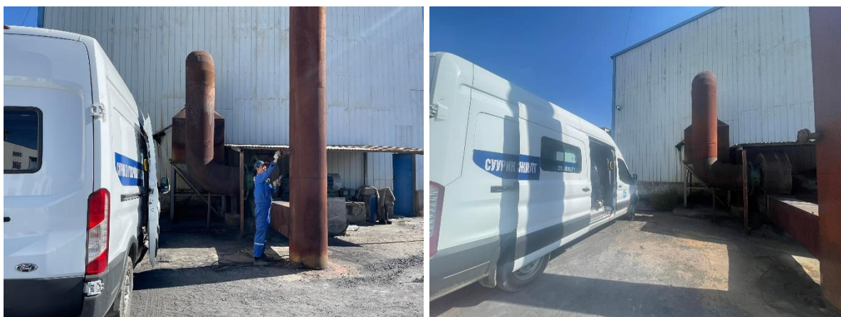
Зураг 40. Уурын зуухны яндангаас ялгарах бохирдуулагчийн хэмжилт хийж буй байдал
