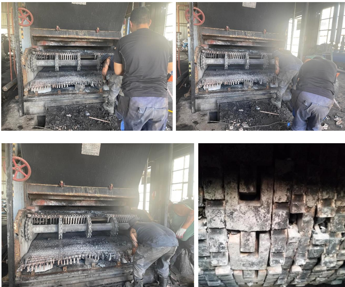
Зураг 9. Уурын зуухны үнсийг цэвэрлэх, ээлжит засвар үйлчилгээ хийж буй байдал
