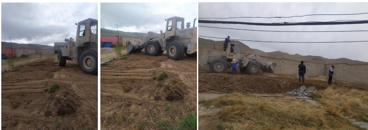
Зураг 17. Биологийн нөхөн сэргээлт хийхээр төлөвлөсөн талбайд техник ашиглан хөрс бэлтгэж буй байдал
