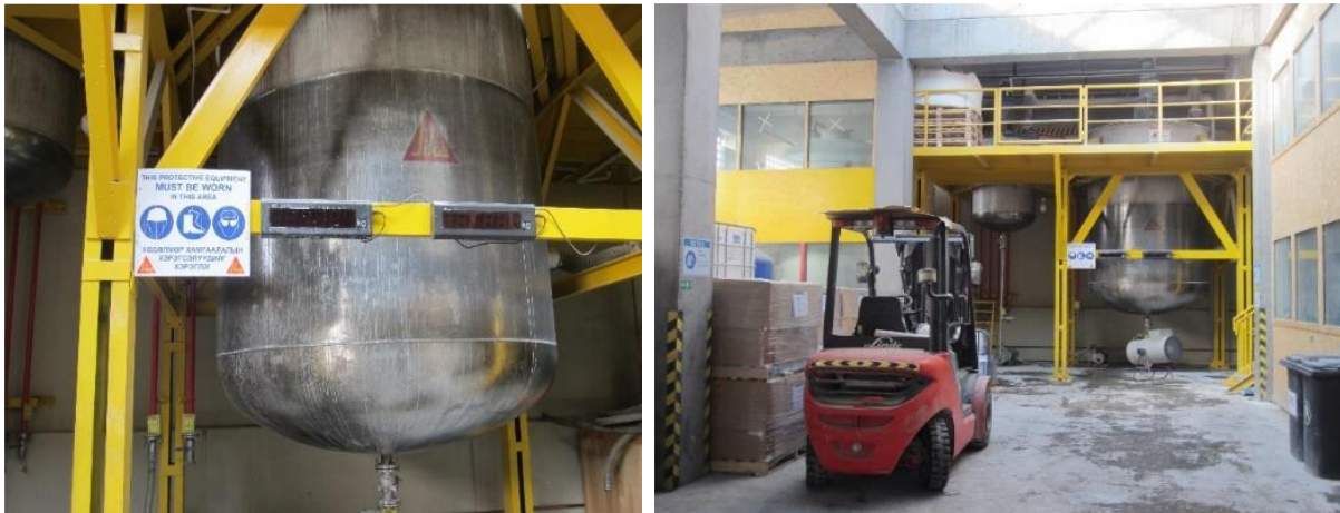
Зураг 1-3. Бетоны нэмэлтийн үйлдвэр
