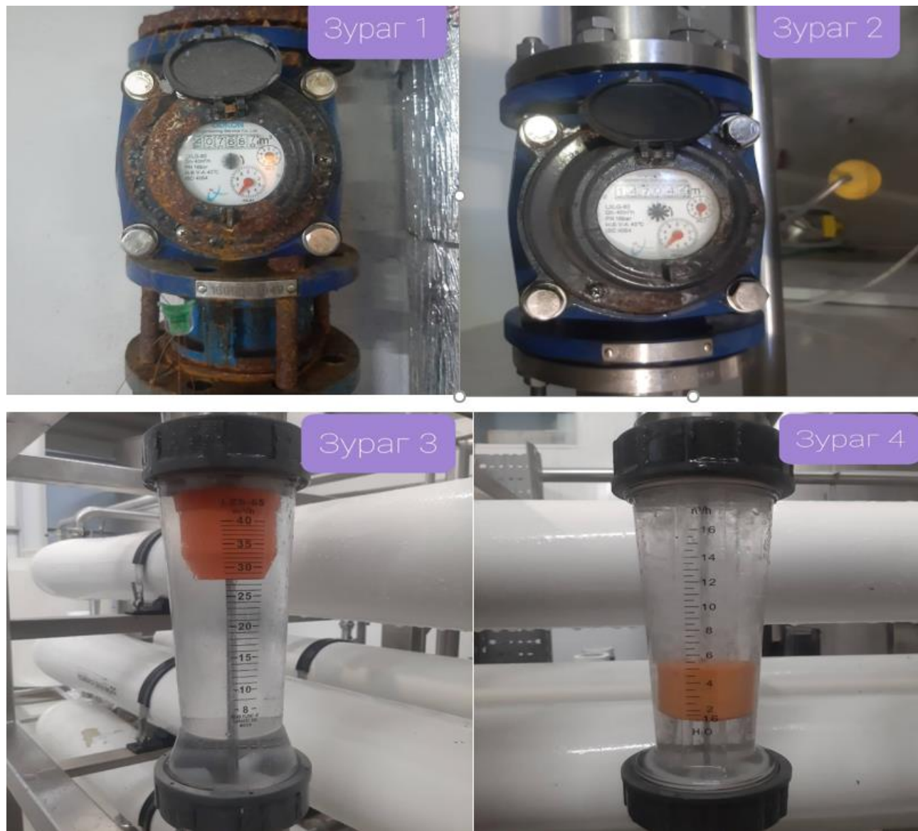
Зураг 1. Түүхий усны ерөнхий тоолуур. Ус боловсруулах систем, хөргөлт, үйлдвэрийн цэвэрлэгээ, вармер, оффис хэрэглээнд ашиглаж буй бүх усны тоолуур
