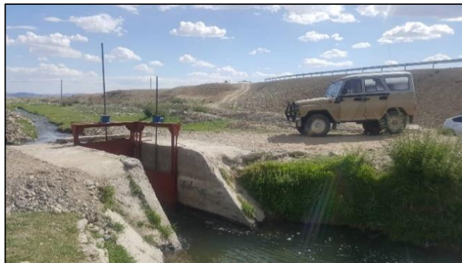
Зураг 3.Толгойн барилгын хаалтуудыг 2019.06.22-нд засварлаж дууссан байдал
