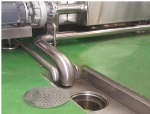
Зураг 9. Үйлдвэрийн шугам хоолой, систем угаасан хаягдал усны гаралтын хэсэг
