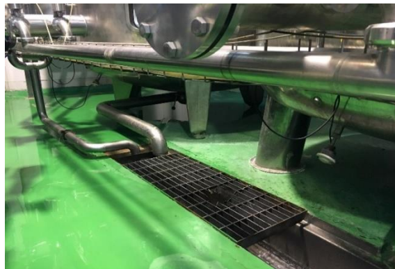
Зураг 10. Систем угаасан ус болон үйлвэрийн байрны цэвэрлэгээнээс гарах хаягдал ус зайлуулах хоолой
