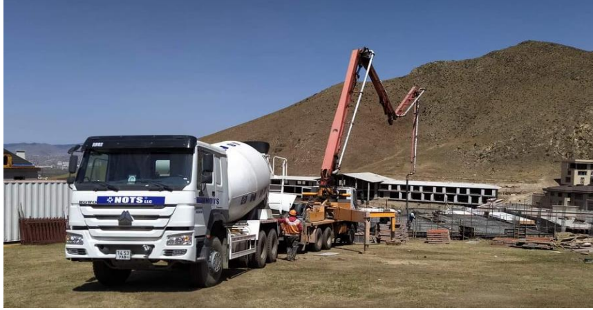
Зураг 11. Бетоныг барилгын талбайд буулгаж буй байдал
