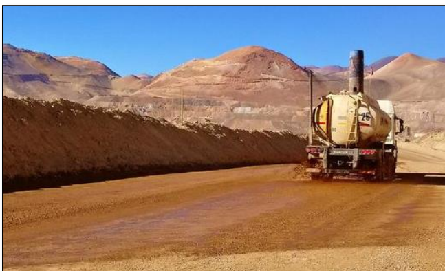
Зураг-8. Хүдэр тээврийн 5.6км урт замд Cypher ROAD//STABILIZR® цацаж буй байдал
