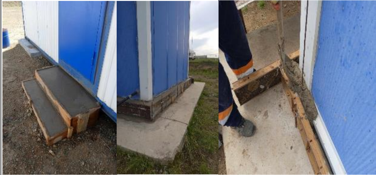
Зураг 31. ҮЙЛДВЭРИЙН БАРИЛГА БАЙГУУЛАМЖ, ШАЛ ЗЭРЭГТ БАЙНГЫН ҮЗЛЭГ ШАЛГАЛТ ХИЙЖ, ЭВДРЭЛ ГЭМТЛИЙГ ЗАСАЖ САЙЖРУУЛСАН.
