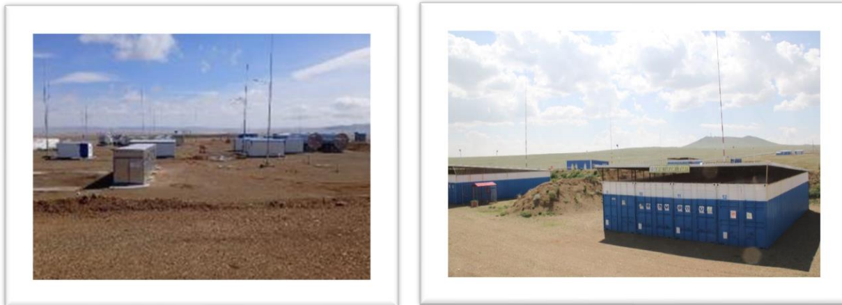
Зураг 12. Үйлдвэр агуулахын цогцолбор харагдах байдал
