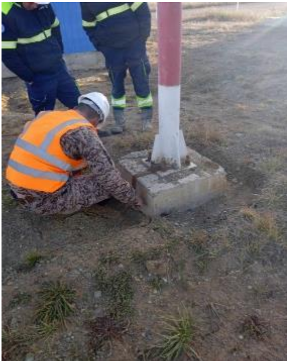
Зураг 41 Зэвсэгт хүчний нэгдсэн лабораториор үйлдвэр, агуулахын газардуулга болон аянга зайлуулагчийн эсэргүүцлийг хэмжүүлсэн
