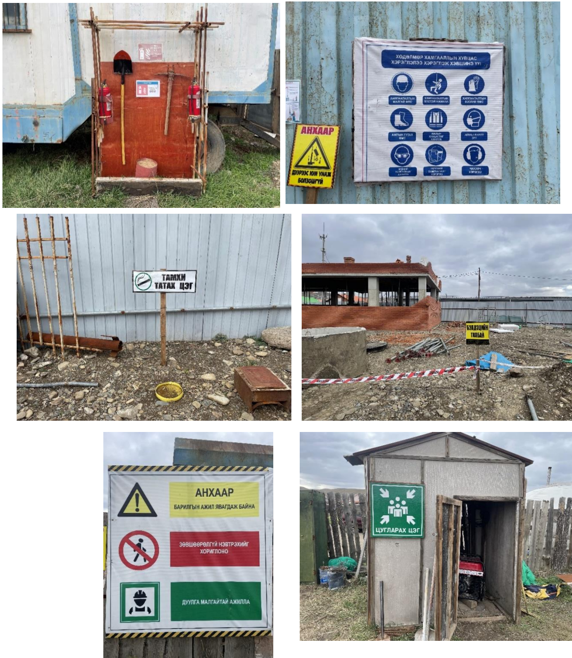
Зураг 17 Ухсан нүх шуудууг хамгаалалтын торон хашаагаар хашиж хүрээлэх, анхааруулах тэмдэг байрлуулсан.
