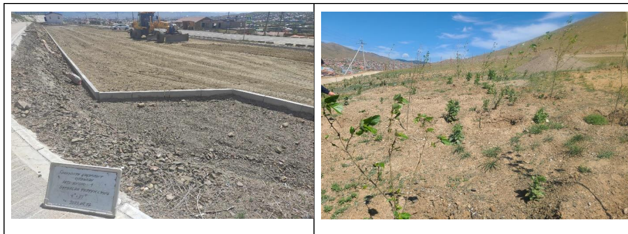
Зураг 9. Нөхөн сэргээлтийн ажил хийгдэж буй байдал
