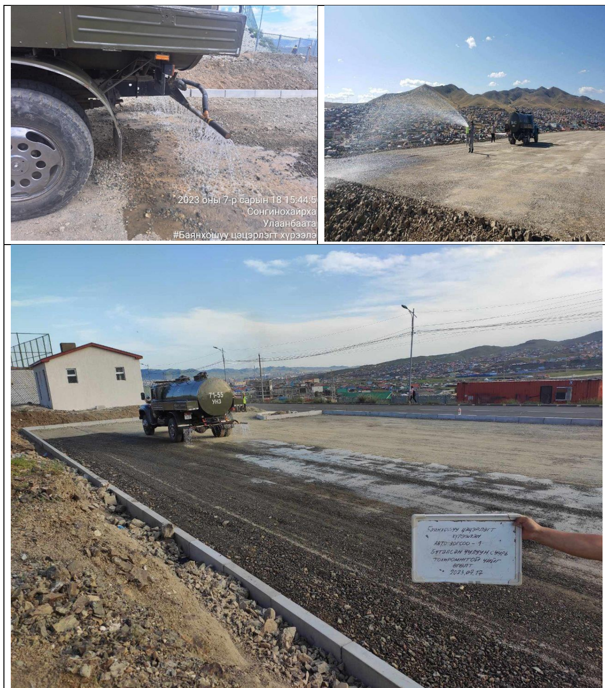
Зураг 8. Усалгаа хийгдэж буй байдал
