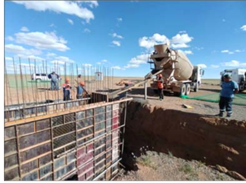
Зураг № 9. Бетон зуурмагийг үйлдвэрээс зуурмагийн машинаар тээвэрлэн авч буй байдал
