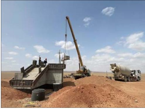
Зураг № 9. Бетон зуурмагийг үйлдвэрээс зуурмагийн машинаар тээвэрлэн авч буй байдал
