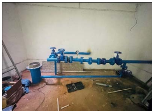
Зураг № 18. Гүний худгийн дотор холболт хийсэн, ашиглалтын цооногийн одоогийн байдал
