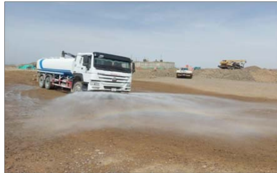
Зураг № 2. Зам талбайн усалгааг хийж маршрутын зам дагуу зорчих тэмдэглэгээ байрлуулсан байдал
