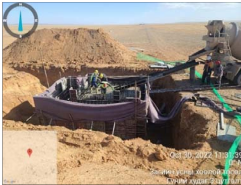
Зураг № 10. Бетон зуурмагийг үйлдвэрээс зуурмагийн машинаар тээвэрлэн авч буй байдал
