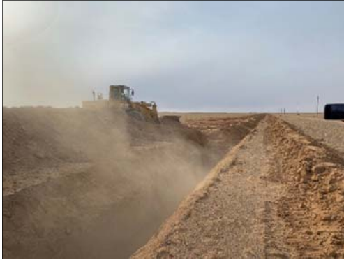
Зураг № 12. Шугам хоолойг угсарч шуудууг технологийн дагуу буцаан булж буй байдал
