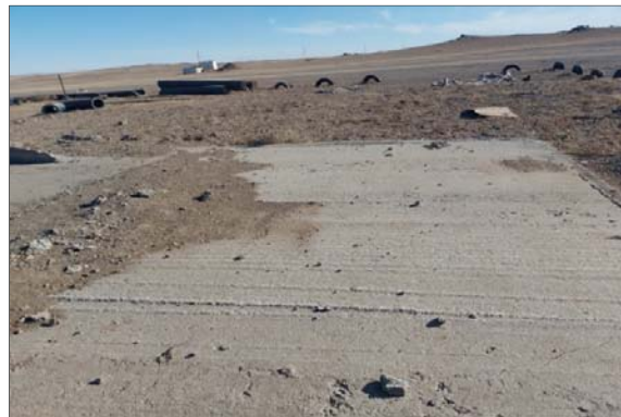
Зураг № 40. Түр засварын талбайг бетон суурьтай болгосон байдал
