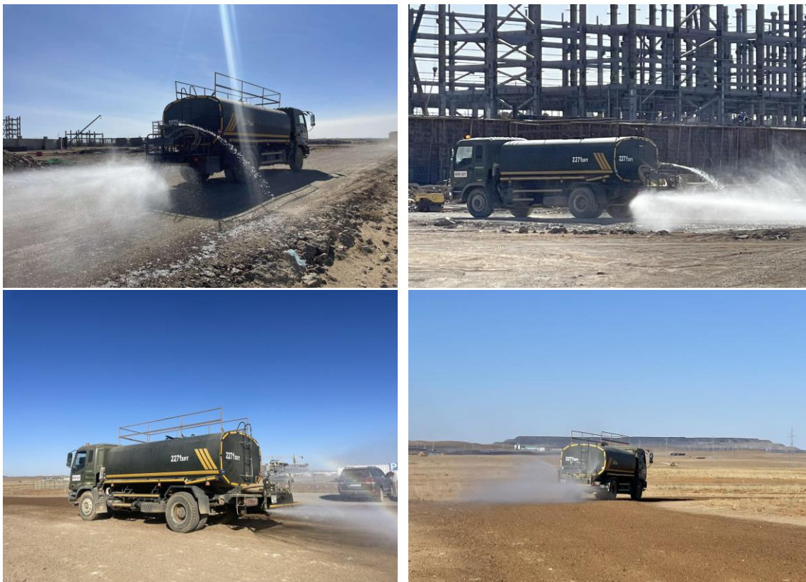
Зураг 6.1 - 6.4 Түр замын тоосжилт дарах усалгаа хийж буй байдал
