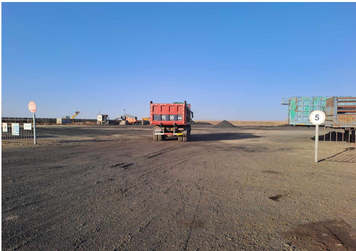
Зураг 9. Дотоод зам талбайд хайрган хучилт хийсэн байдал
