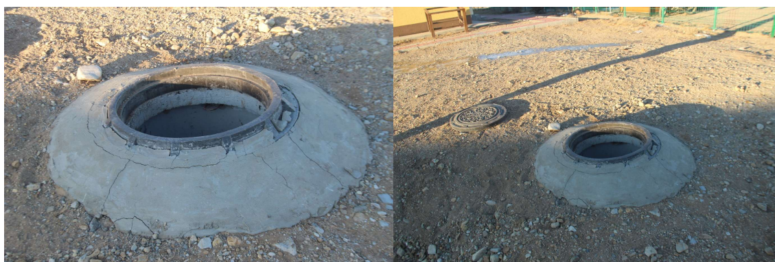
Зураг 18. Бохирын цооног байгуулсан байдал
