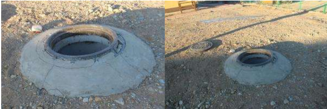
Зураг 15. Бохирын цооног байгуулсан байдал
