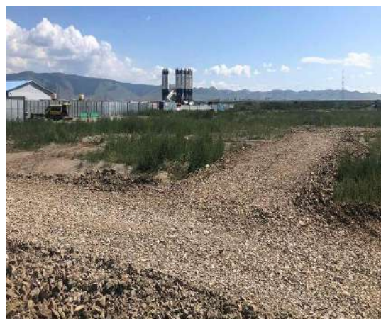
Зураг 4-14: Автосамосвалаар 18м 3 дайрга буулгаж гарах хаалганы хонхойсон замыг ковшиор түрж тэгшилжэ буй байдал
