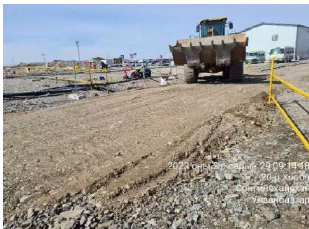
Зураг 4-14: Автосамосвалаар 18м 3 дайрга буулгаж гарах хаалганы хонхойсон замыг ковшиор түрж тэгшилжэ буй байдал
