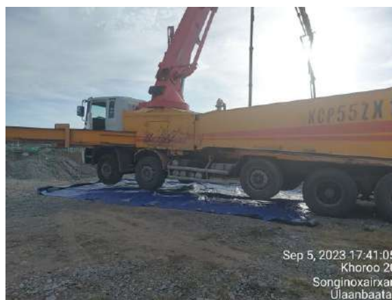
Зураг 4-22: Бетон цутгалтын ажлын үед хөрсийг хамгаалж буй байдал
