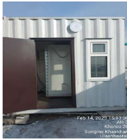
Гүний худагт 1 тонн багтаамж бүхий усны танк суурилуулсан байдал
