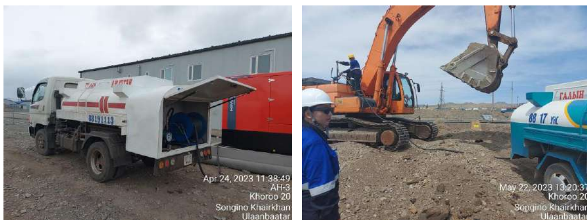
Зураг 4-17: УДБҮ-ийн төслийн талбайд зориулалтын машинаар түлш цэнэглэлт хийгдэж буй байдал
