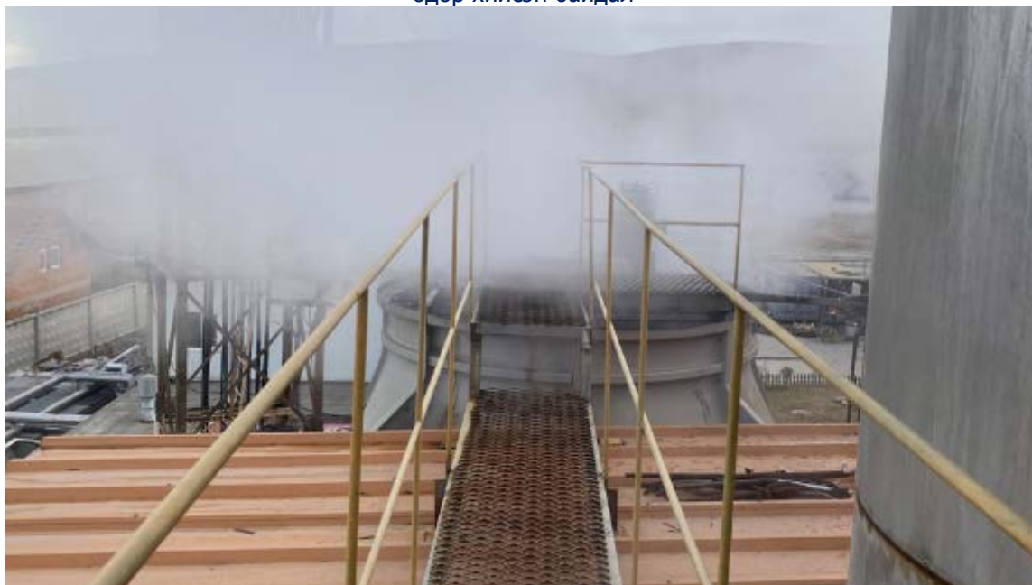
Зураг 1.3. Хөргөх цамхагийн үзлэгийн шат тавцанг 2023 оны 06-р сарын 30-ны өдөр шинээр хийж байршуулсан байдал
