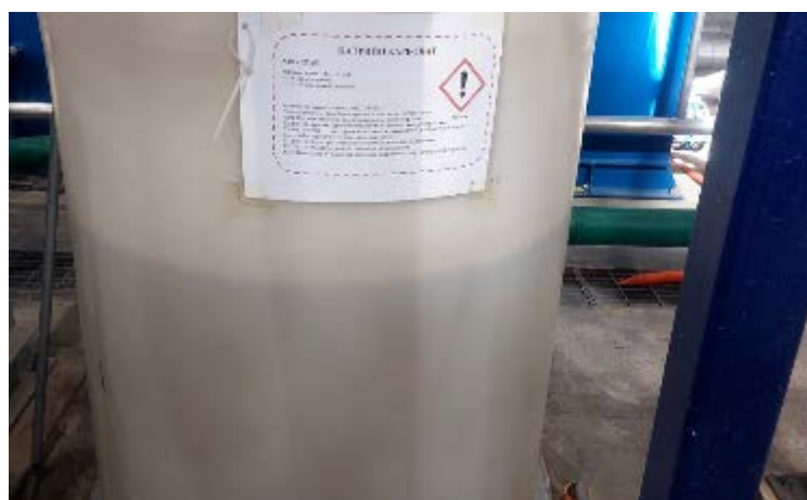
Зураг 3.3. Химийн бодисын агуулах болон Үйлдвэрт ашиглаж буй химийн бодисын ХАЛМ болон аюулгүй ажиллагааны зааварчилгааг байрлуулсан байдал
