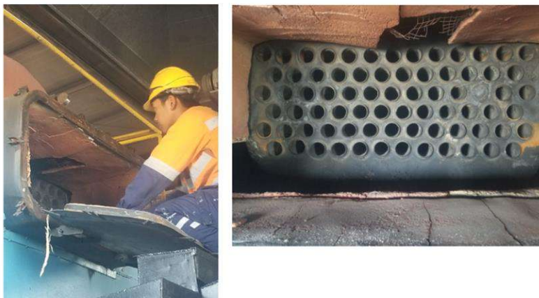
Нөөцөнд байгаа хоёрдугаар зуухны экра хоолойнд үзлэг хийж цэвэрлэв.
