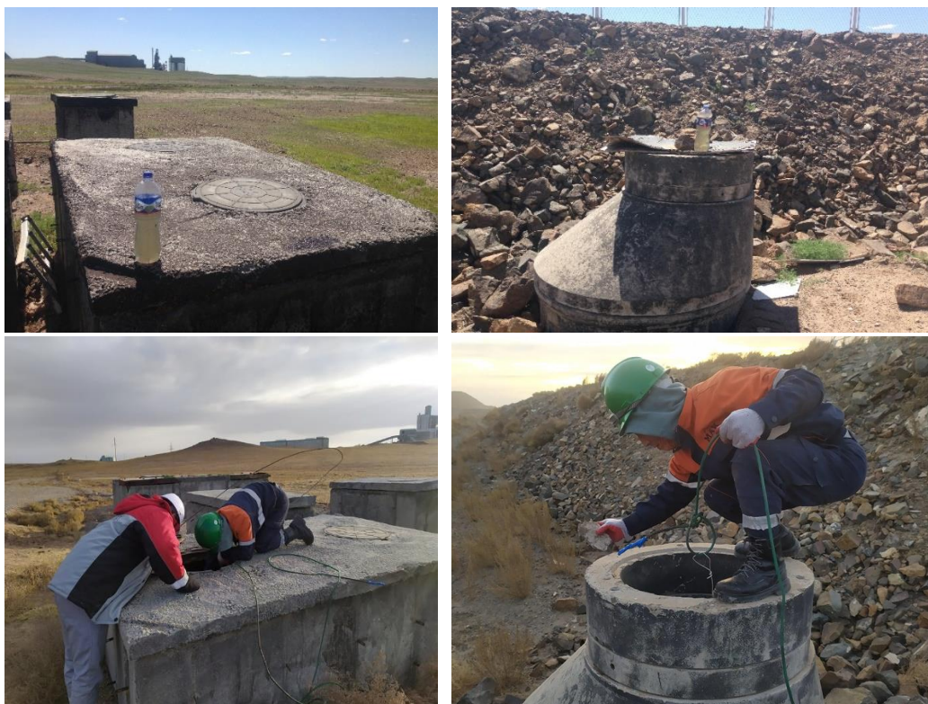
Зураг 40. Бохир усны шинжилгээ авч буй байдал
