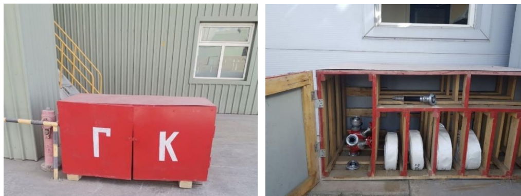
Зураг 29. Галын гидрантуудын ажиллагааг шалгаж бүрэн бүтэн байдлыг хангасан
