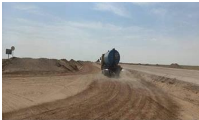
Зураг 11. Түр замын усалгааг тогтмол хийж буй байдал
