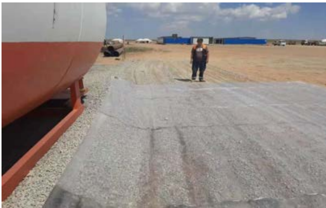
Зураг 46. Шатах тослох материалын асгаралт хөрс, усанд шингэхээс сэргийлсэн байдал
