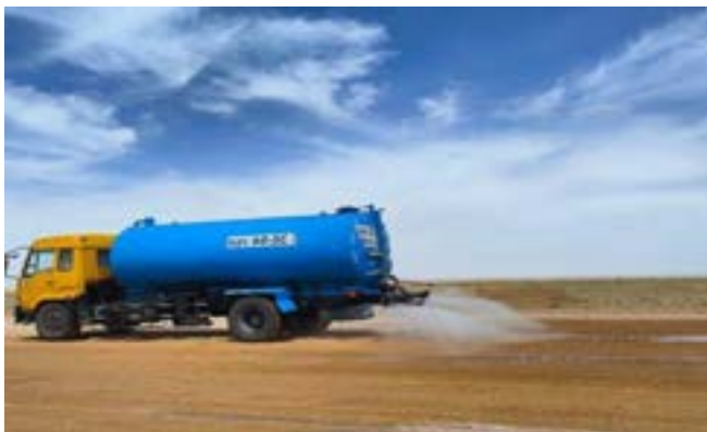
Зураг 11. Түр замын усалгааг тогтмол хийж буй байдал
