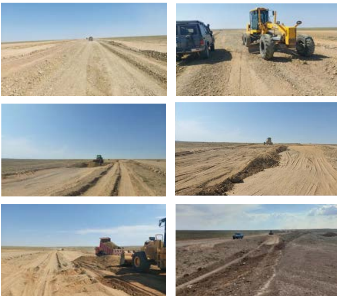
Зураг 7. Түр замын арчилгаа сайжруулалт хийж буй байдал /Дорноговь аймаг/
