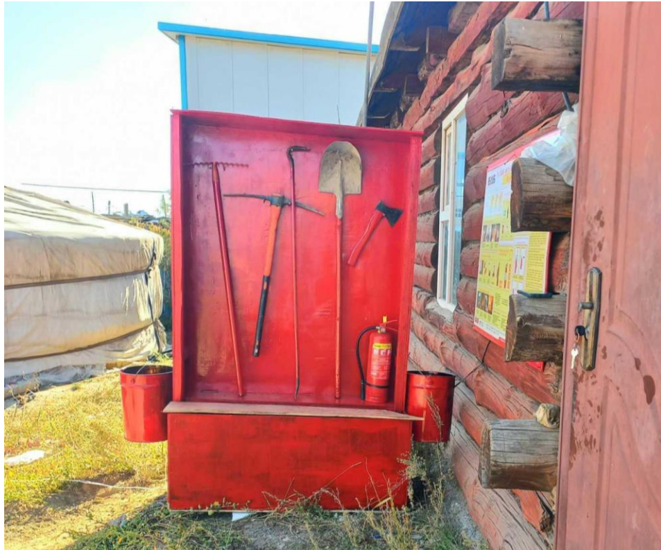
Зураг 10. Төслийн талбайд байршуулсан галын хор, сарааны зураг
