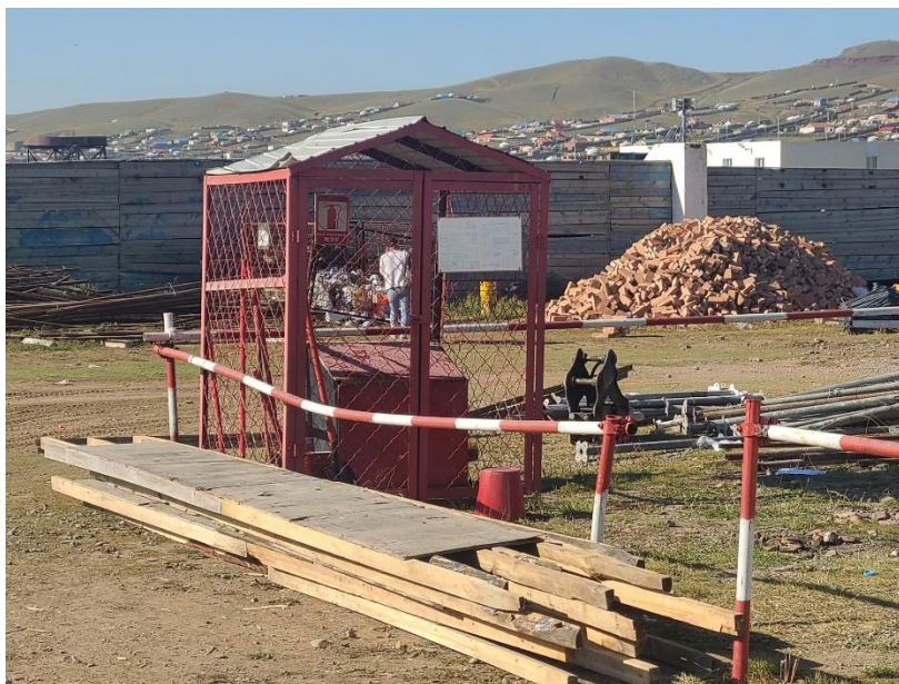
Зураг 7 Гал унтраах багаж төхөөрөмж
