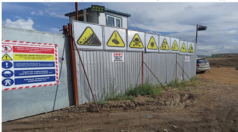
Зураг-8.8. Барилгын ажил явагдаж буй талбайг хашаажуулсан байдал.
