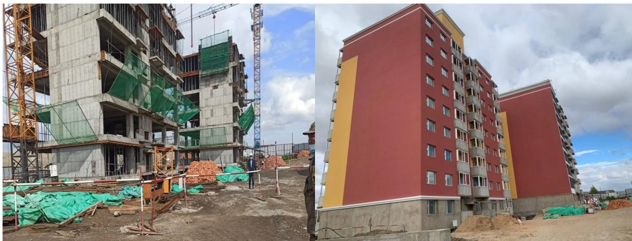
Зураг-8.7. Барилга үеийн хашилт, хаалт ашигласан байдал.
