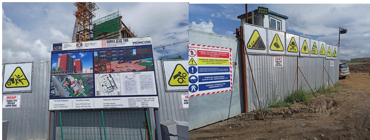
Зураг-4.7. Барилгын ажил явагдаж буй талбайг өндөр хашаагаар тусгаарлсан байдал.
