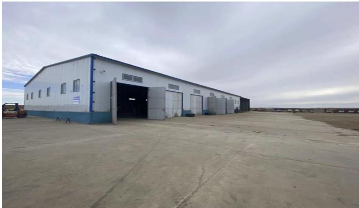
Зураг 5-12. Засвар үйлчилгээний төвийн барилга
