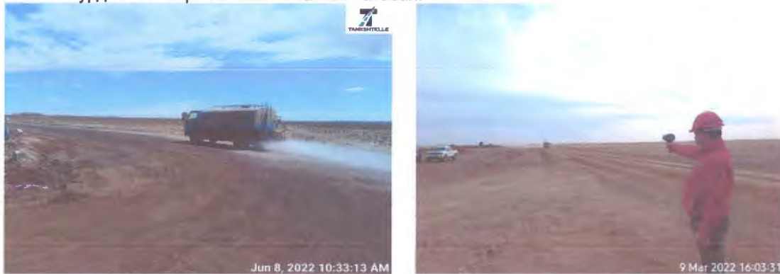
Зураг 2.2. Түр замын усалгаа, түр замын хяналт хийж буй байдал
