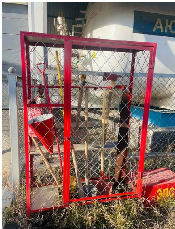
Зураг 5.6. Үйлдвэрийн хэмжээнд хойд болон зүүн хэсэгт 2 галын сарай /Гал унтраах анхан шатны иж бүрдэл/, гал унтраагуур 28ш, галын гидрант 4ш, автомат гал унтраагуур болон галын дохиололын автомат системд холбогдсон. Сургалтанд ашигласан 4ш галын хорыг баталгаажуулсан байдал.
