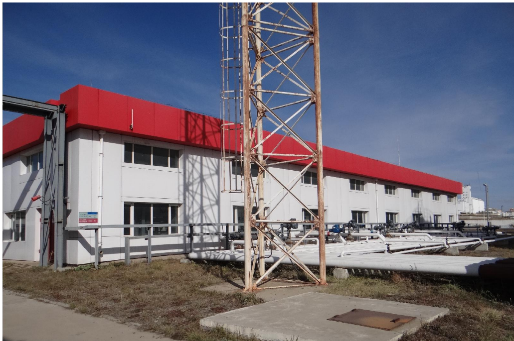
Зураг 2. Вагон насос станцын барилга
