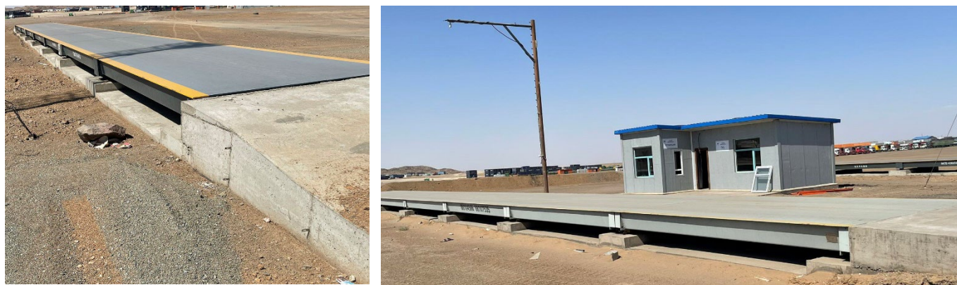
Зураг 5. Гаалийн хяналтын талбайд байрлуулсан 200 тонны цахилгаан пүү
