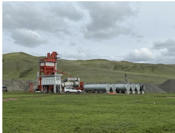
Зураг 6. Асфальт бетоны үйлдвэр /CH41+000/
