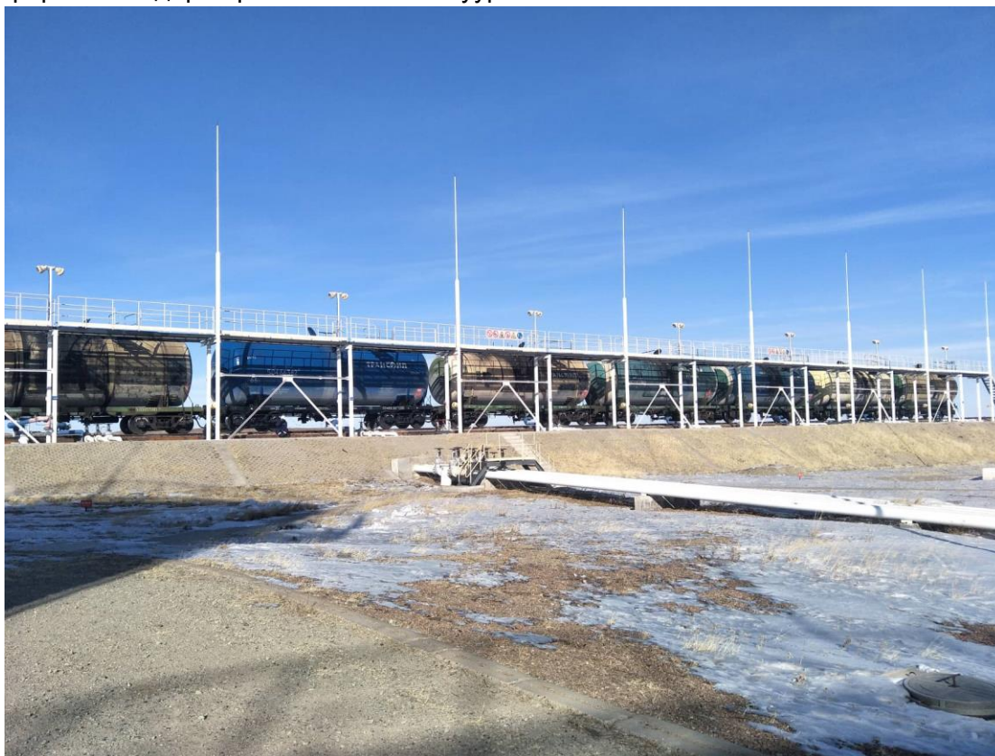
Зураг 3. Вагонцистернээс шатахуун буулгах байгууламж
