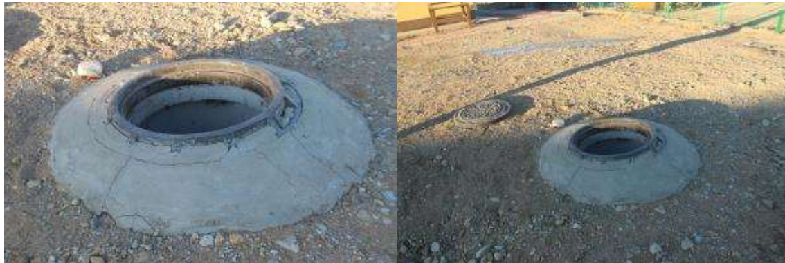
Зураг 15. Бохирын цооног байгуулсан байдал
