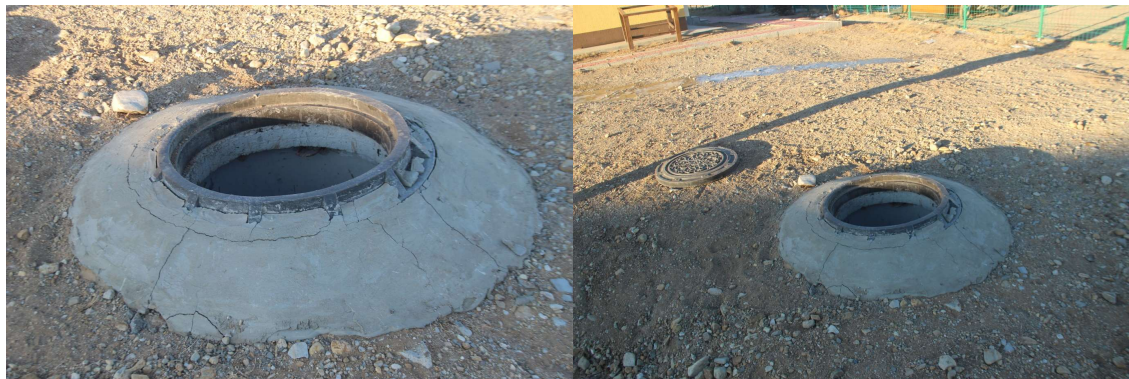
Зураг 18. Бохирын цооног байгуулсан байдал
