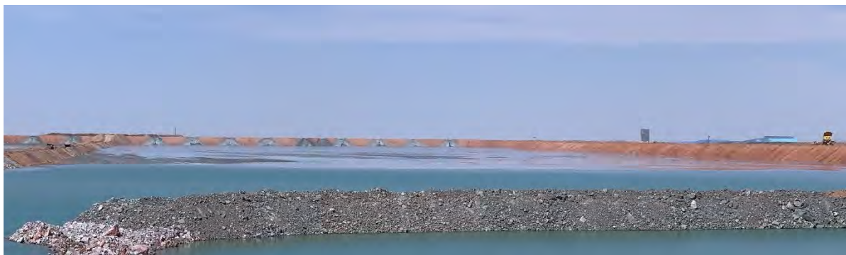
Зураг 2-27. Эргүүлэн татах цөөрмийн (Barge Pond) устай хэсэг болон олон хоолойгоор хаягдал хаяж байгаа байдал
