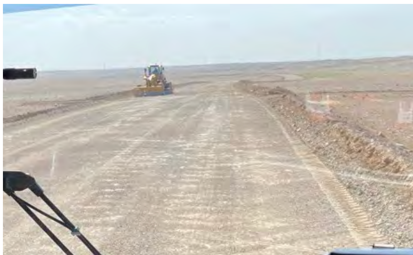
Зураг 2-4. Зам засвар хийж буй байдал – Ханбумбатын нисэх буудлын зам
