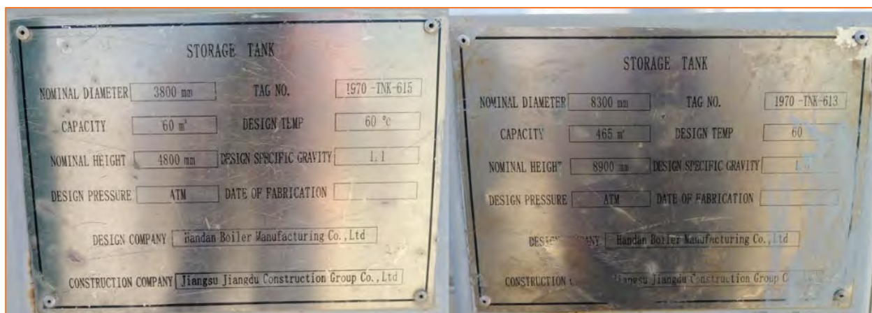
Зураг 8-22. Ил уурхайн техникийн хаягдал тос цуглуулах танкны үзүүлэлт
