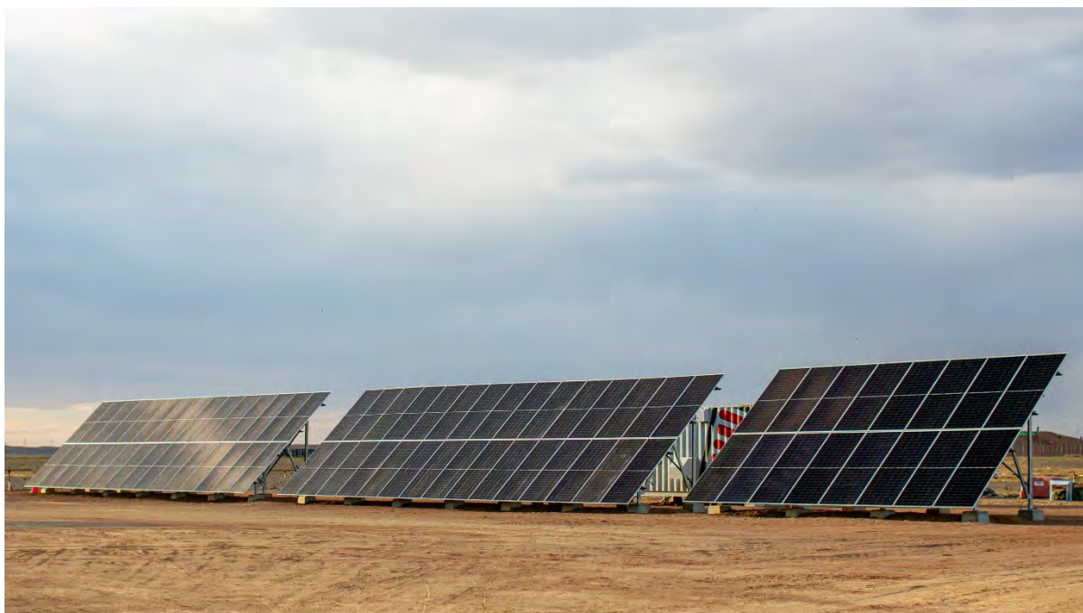
Зураг 2-1. Оюу толгой уурхайн талбайд байрлах Тэсрэх бодисын агуулахын 30кВт-н хүчин чадалтай Нарны эх үүсвэртэй зай хураагуур-дизель генератор хосолсон систем
