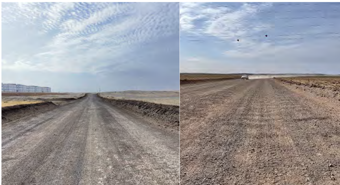
Зураг 2-13. Тоос дарагч бодис цацсан (зүүн, 1-р хэсэгт) болон цацаагүй (баруун, 2-р хэсэгт) замын хэсгүүдийн харьцуулалт
