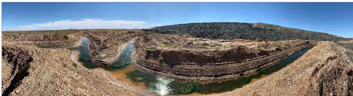
Зураг 9-13. Шүүрлийн усыг шуудуугаар цуглуулж байна
