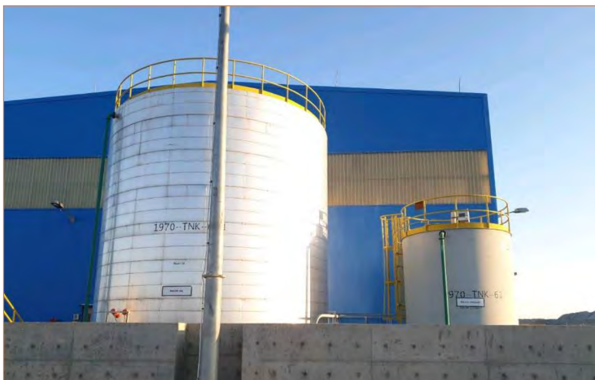
Зураг 8-23. Ил уурхайн техникийн хаягдал тос цуглуулах танк
