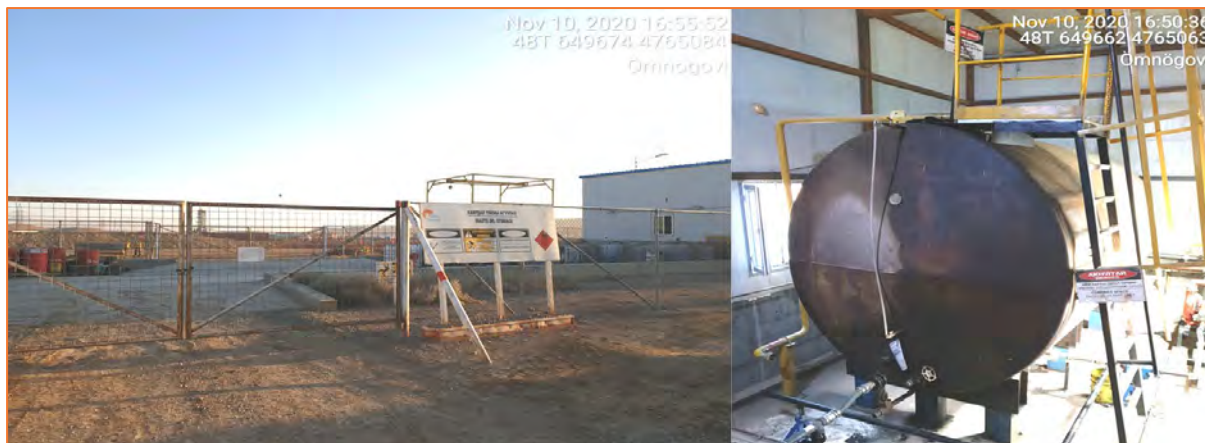
Зураг 8-24. Хөдөлгөөнт тоног төхөөрөмжийн засварын газрын хаягдал тос цуглуулах танк
