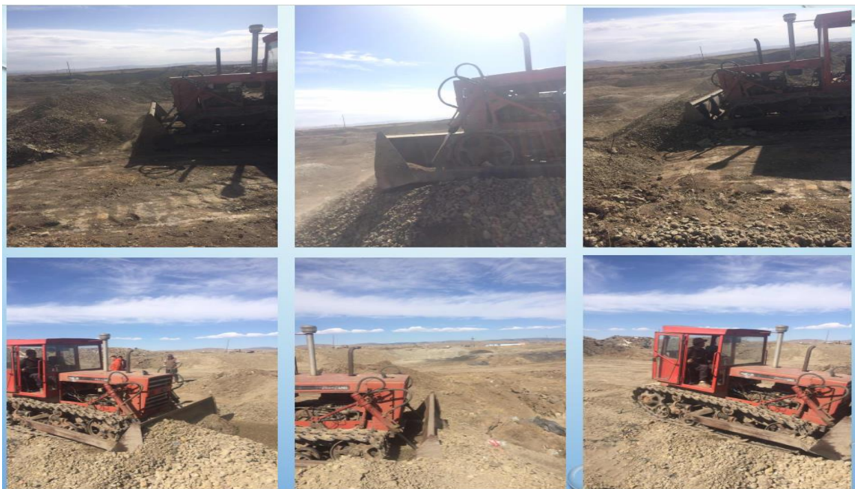
Зураг 3.3. Эвдэрсэн талбайг түрж тэгшилж байгаа нь
