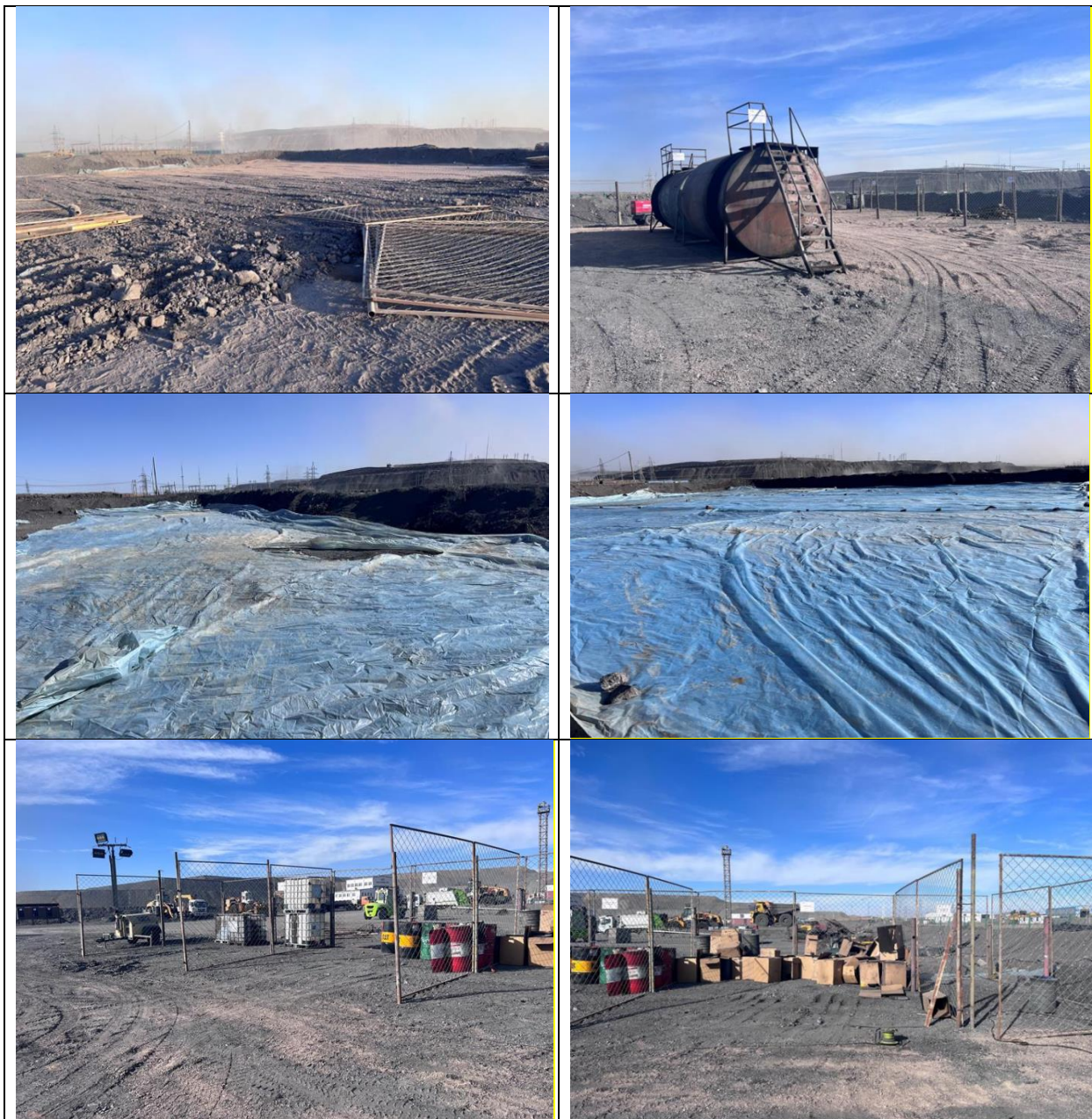
Зураг № 93. Засварын шопийн аюултай хог хаягдлын талбайд дэвсэлт хийж, ангилан ялгах хашаа хийсэн байдал
