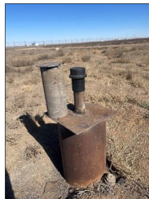
Зураг № 124. Цооногийг хяналтын цооног болгон тохижуулсан байдал
