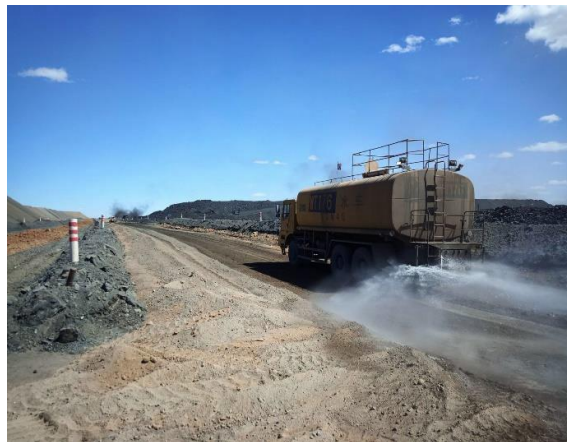
Зураг № 14. Замыг бэлтгэн дэвсэлт хийж бодис цацаж буй байдал
