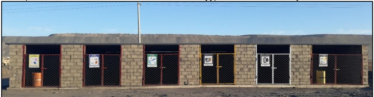
Зураг № 99. Аюултай хог хаягдал түр хадгалах байрны зураг
