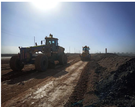
Зураг № 18. Дэвсэлтийг нягтруулж бодис цацаж буй байдал
