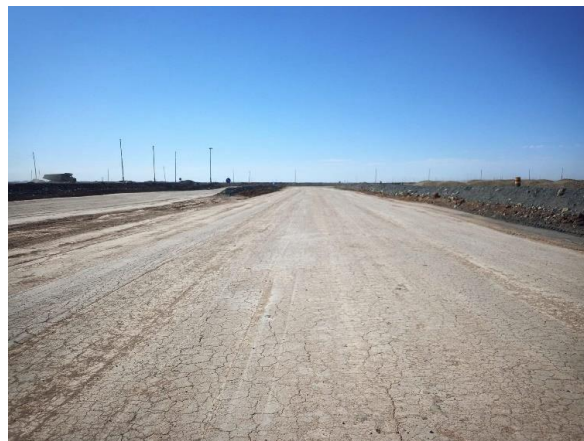
Зураг № 8. Замын тоосжилт барьцалдуулагч бодис хэрэглэсний дараах болон хэсэг хугацааны дараах харьцуулсан зураг
