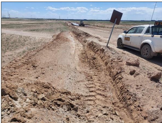
Зураг № 30. Замын 2 талын хаяаг машин давахгүй байдлаар өндөрлөж буй байдал
