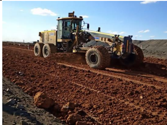
Зураг № 17. Замын дэвсэлт хийж буй байдал
