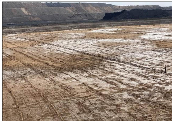
Зураг № 44. Шимт хөрсний овоолгын хэлбэржүүлэлт, усалгаа систем суурилуулсан байдал
