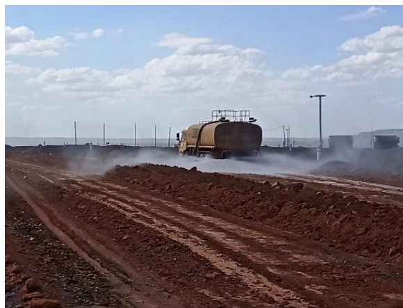
Зураг № 18. Дэвсэлтийг нягтруулж бодис цацаж буй байдал
