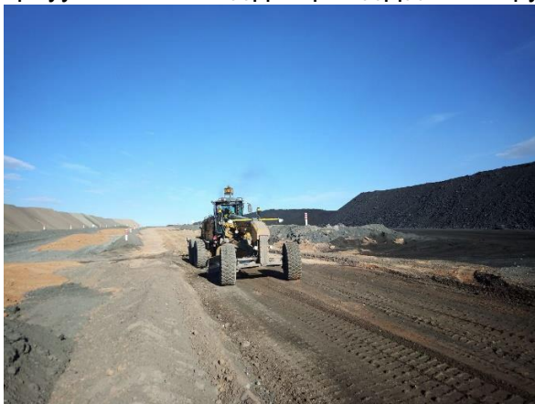
Зураг № 14. Замыг бэлтгэн дэвсэлт хийж бодис цацаж буй байдал
