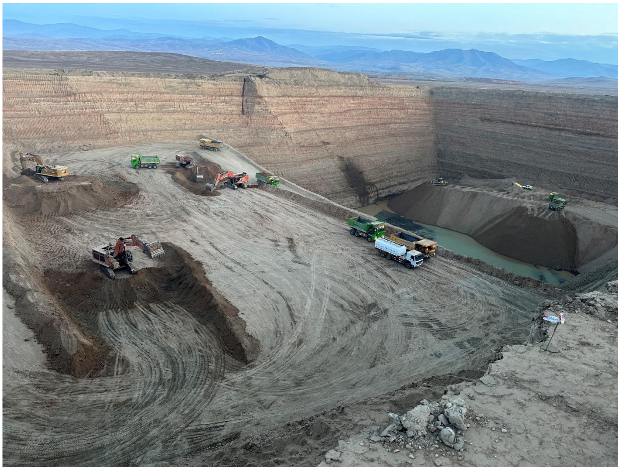
Зураг 12. Дотоод овоолго үүсгэж буй байдал
