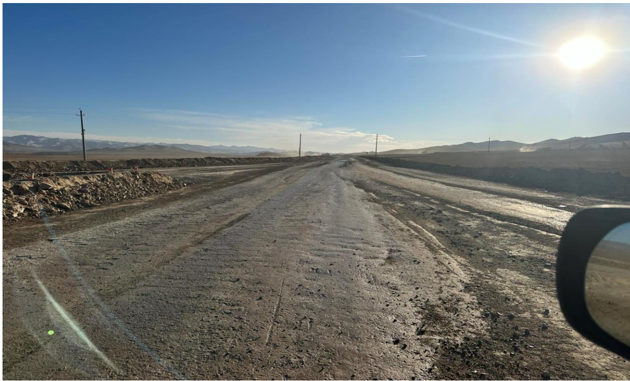
ЗУРАГ 6. ТООСЖИЛТ БУУРУУЛАХ УСАЛГАА ХИЙГДСЭН БАЙДАЛ
