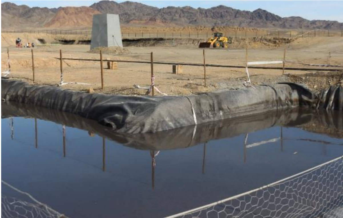
Зураг 20. Өрөмдлөгийн шингэний хаягдлын сан байгуулсан байдал Номгон – 10 цооног
