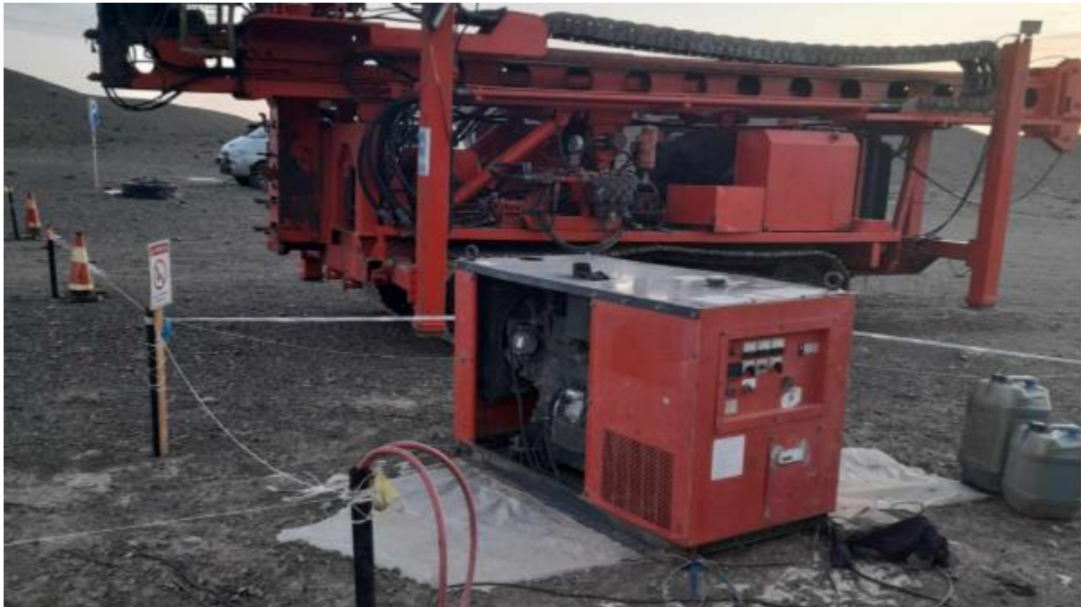
Зураг 14. Хөрсний бохиролтоос сэргийлж генераторын доор пилонк дэвссэн байдал
