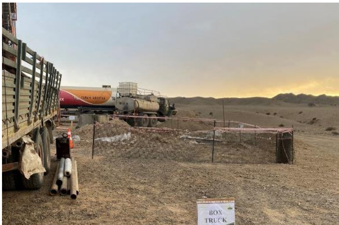
Зураг 19. Өрмийн талбайг хашиж хамгаалсан байдал
