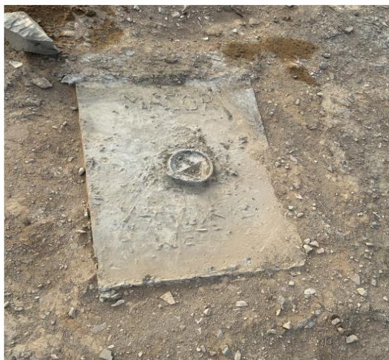
Зураг 34. Yangir West-2, үнэлгээний цооногийг битүүмжилсэн байдал
