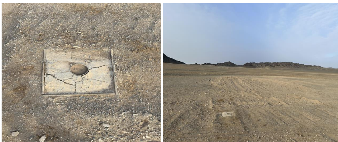
Зураг 30. Big Slope-7 үнэлгээний цооногийг битүүмжилсэн байдал
