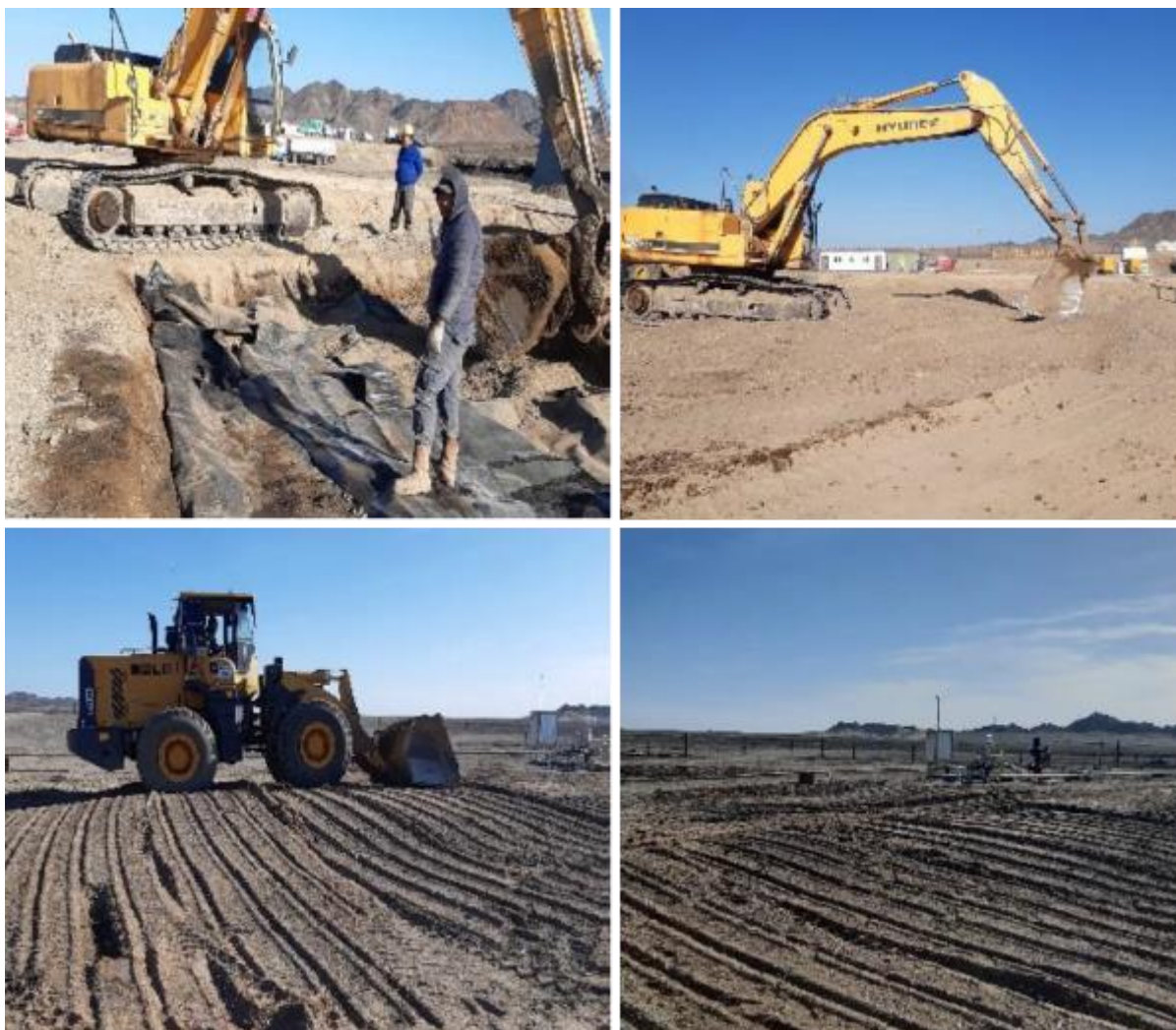
Зураг 45. Номгон – 10 цооногийн талбайд нөхөн сэргээлт хийж буй байдал
