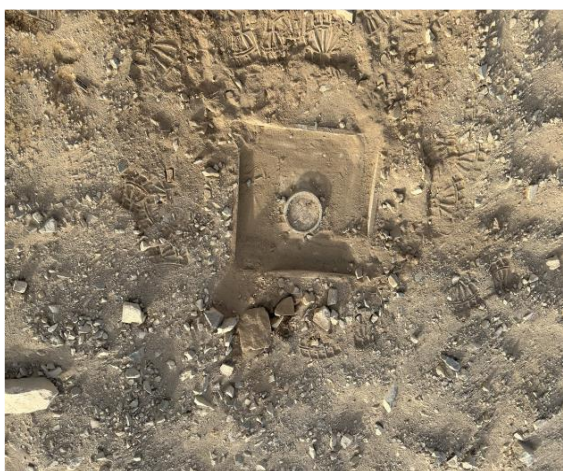
Зураг 32. Big Slope West-1S, хайгуулын цооногийг битүүмжилсэн байдал
