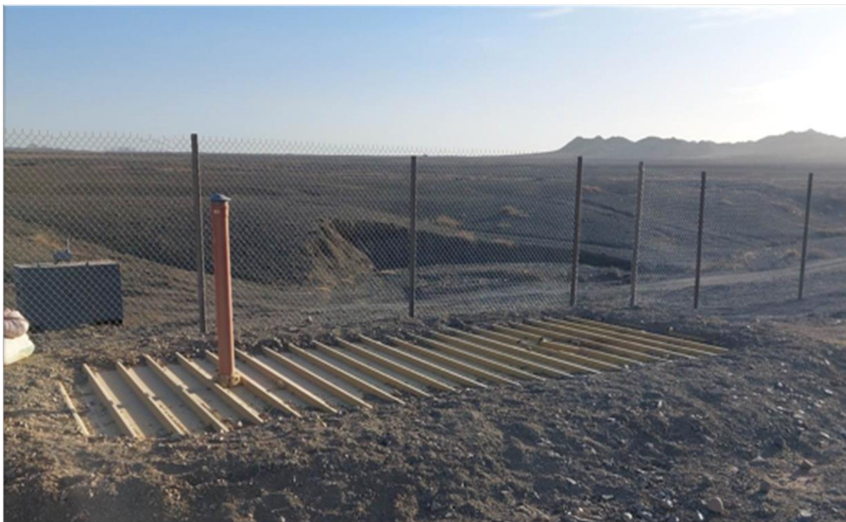
Зураг 57. Туршилтын олборлолтын талбайн шингэн хаягдлын цооног
