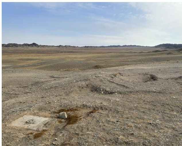
Зураг 34. Yangir West-2, үнэлгээний цооногийг битүүмжилсэн байдал
