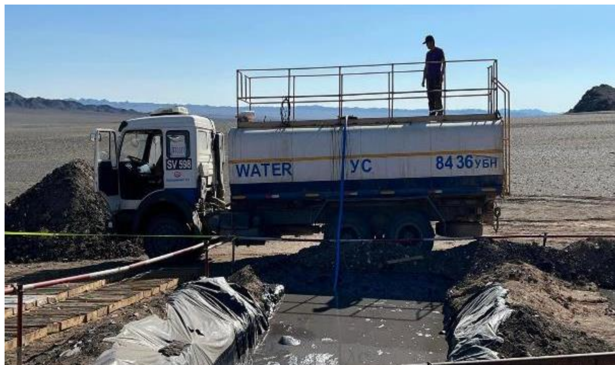
Зураг 63. Өрөмд ашигласаг шингэнийг соруулж буй байдал
