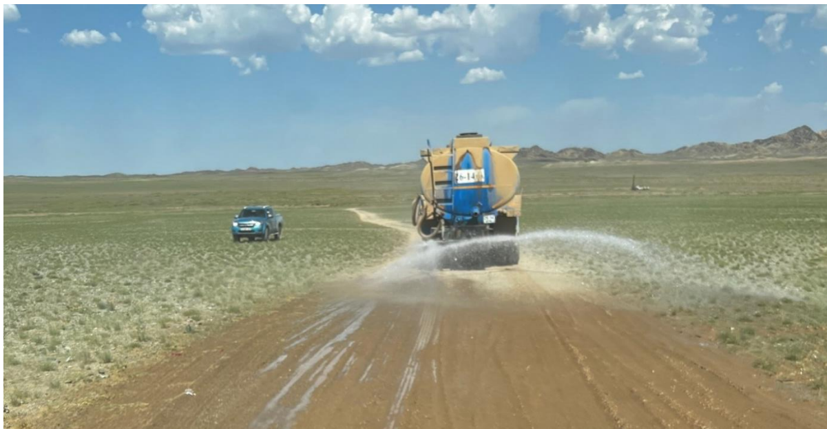
Зураг 12. Тоосжилт бууруулах үүднээс шороон замын усалгаа хийж буй байдал
