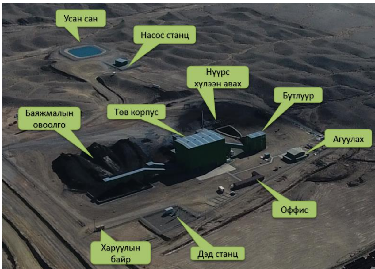
Зураг 9. Нүүрс нойтон баяжуулах үйлдвэр
