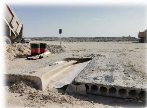
Зураг 22. Уурхайн засвар үйлчилгээний зарим хэсэгт байршуулсан хатуу хучилт
