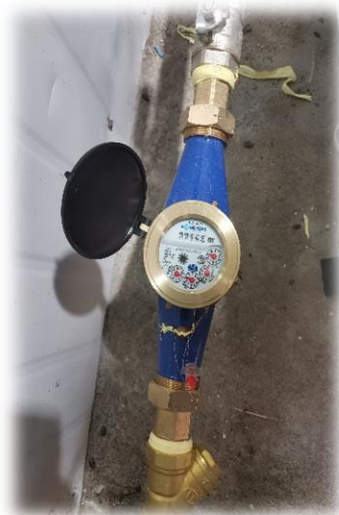
Зураг 40. Ундны усыг хангаж буй гүний худгийн эх үүсвэрт тоолууржуулсан байдал
