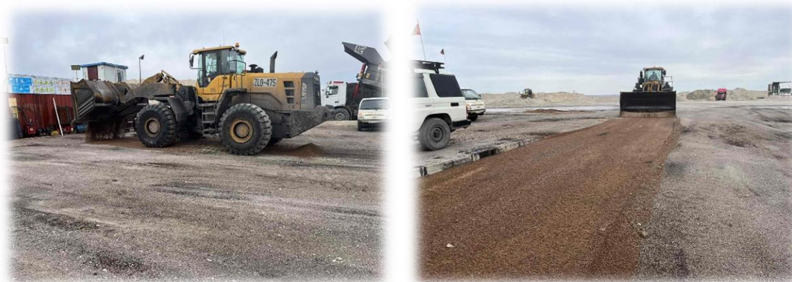
Зураг 21. Уурхайн засвар үйлчилгээний хэсэгт хайрга давхар хийж байгаа байдал талбайг хатуу хучилт хийж хөрсний бохирдлоос хамгаалсан байдал
