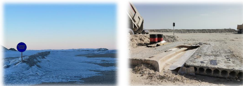
Зураг 21. Уурхайн засвар үйлчилгээний хэсэгт хайрга давхар хийж байгаа байдал талбайг хатуу хучилт хийж хөрсний бохирдлоос хамгаалсан байдал
