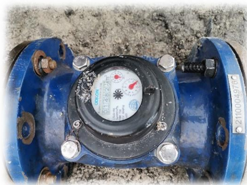
2023.05.03-ны уурхайн шүүрлийн усанд тоолуур суурилж байгаа байдал
