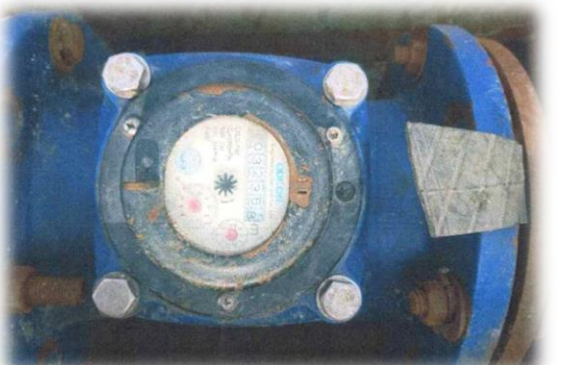
2023.10.02-ны уурхайн шүүрлийн усны тоолуур баталгаажуулалт
