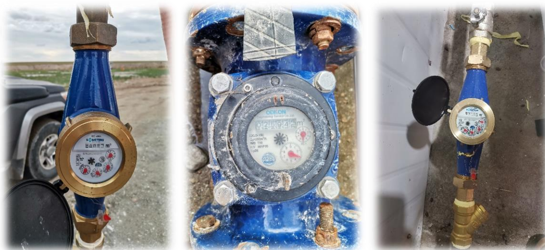
Зураг 7. Хашаатын цав уурхайн шүүрлийн ус, ногоон байгууламжийн усалгааны болон унд-ахуйн зориулалтаар ашигладаг гүний худгуудыг тоолууржуулсан байдал
