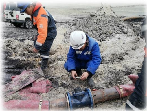
2023.05.03-ны уурхайн шүүрлийн усанд тоолуур суурилж байгаа байдал
