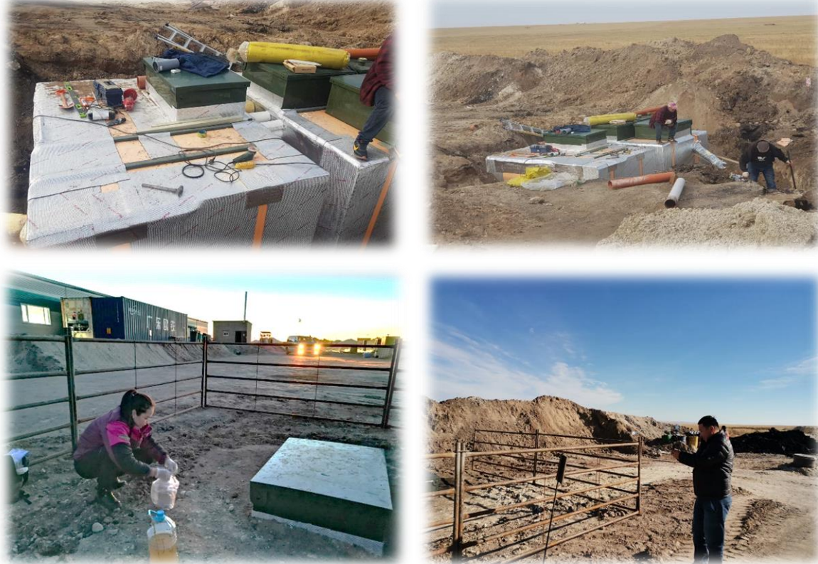
Зураг 37. Кемпийн талбай дээр суурилуулж буй бага оврын цэвэрлэх байгууламж барьж байдал
