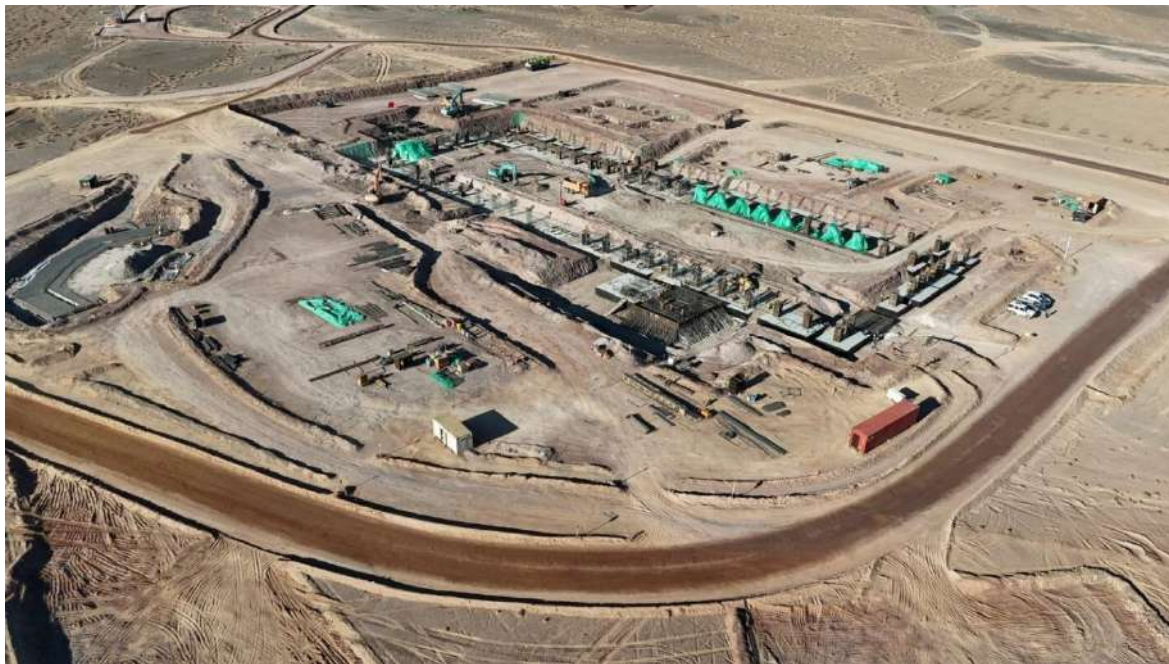
Зураг 8. Баяжуулах үйлдвэрийн барилгын явц
