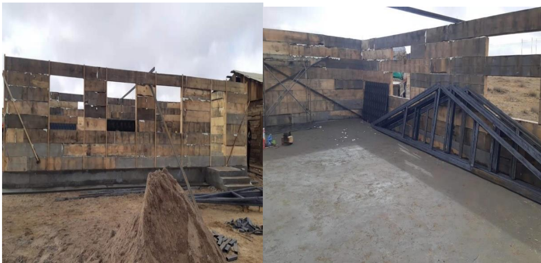
Зураг № 13 Бичигт багийн байр барьж буй
