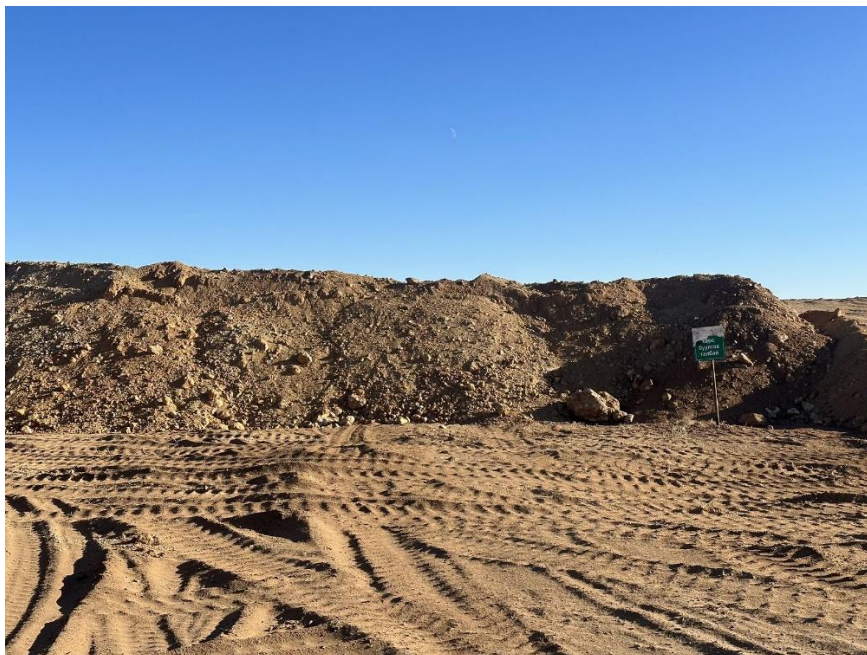
Зураг № 16 Шимт хөрсний овоолго үүсгэсэн байдал
