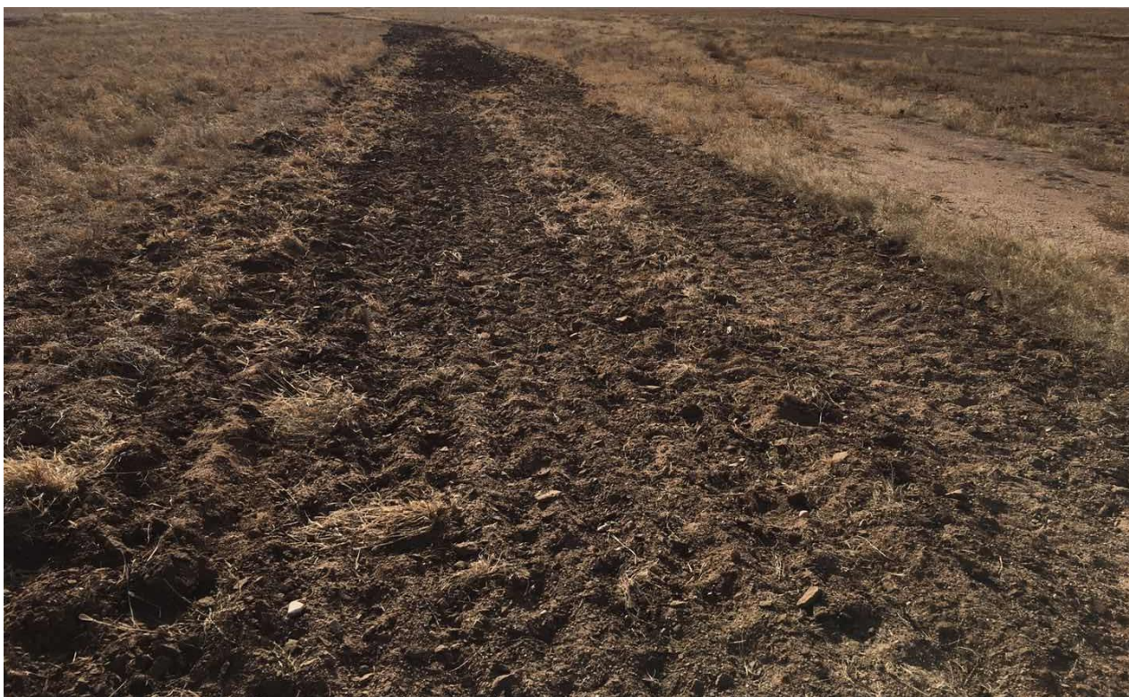
Зураг № 19 Ашиглагдахгүй болсон замыг хаглаж бутлаж сийрүүлсэн байдал
