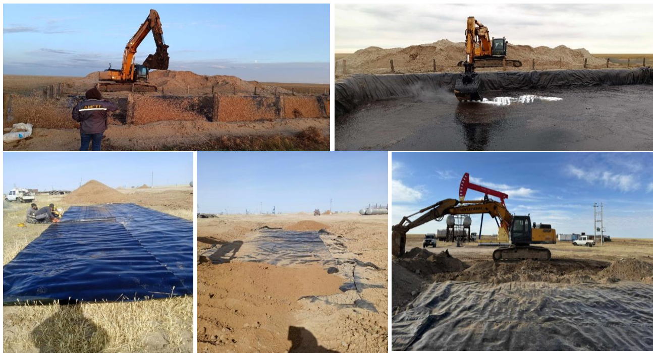
Зураг № 25. Өрмийн шингэн хаягдлын санд техникийн нөхөн сэргээлт хийж буй нь
