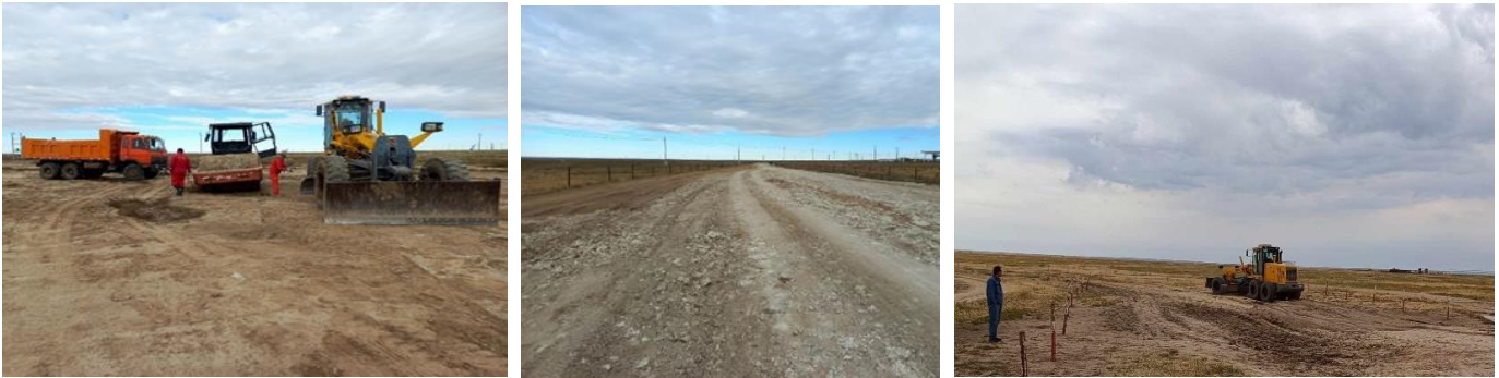
Зураг № 12. Зам арчлалт хийж буй байдал
