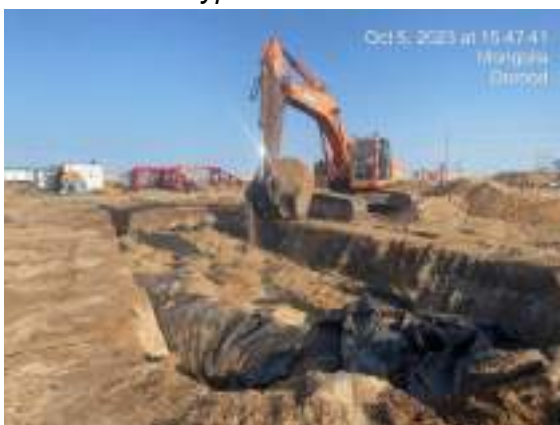
Зураг-23. Өрмийн сан бүрэн хатаж хатуу төлөв байдалд орсны дараа геомембрамаар өлгийдөх
