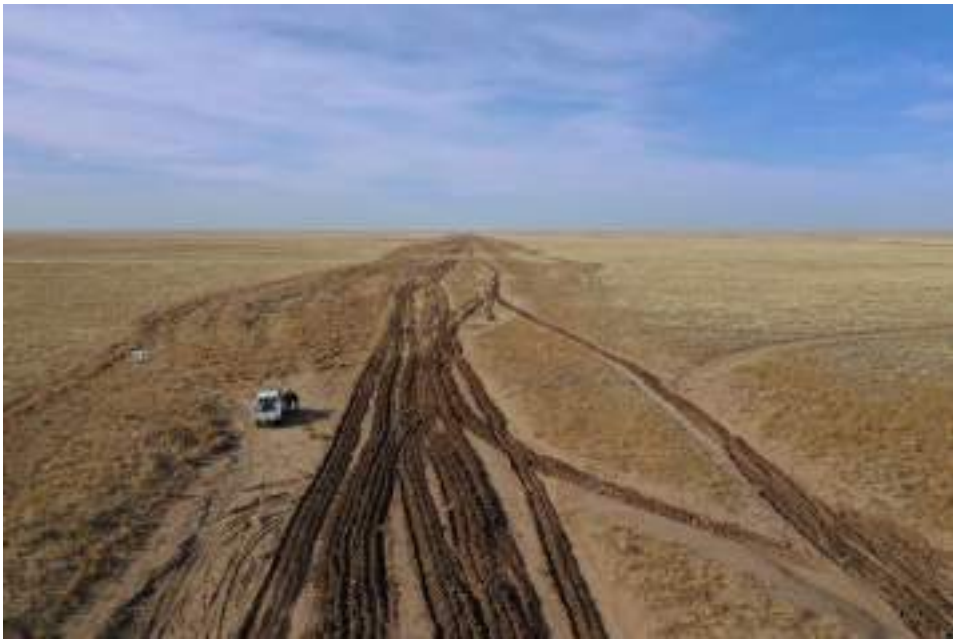
Зураг-17. Ашиглалтаас гарсан замыг хагалж буй байдал
