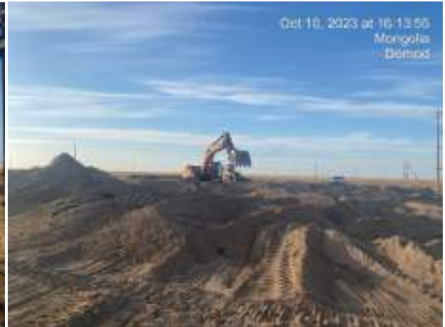
Зураг-24. Шар шороон хөрсөөр дүүргэлт хийх/В хөрс/ хучих, хэлбэржүүлэх /харьцангуй өндөр нь 50см ихгүй байх/
