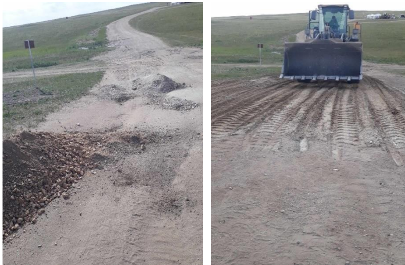
Зураг 2. Зам талбайг засаж буй байдал
