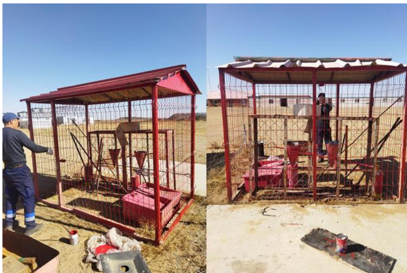
Зураг 28. Галын буланг сэргээн засаж, галын хорыг шинэчлэв.
