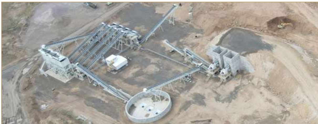
Зураг 21. Шинэ бутлуурын барилга бүтээн байгуулалтын ажлын явц
