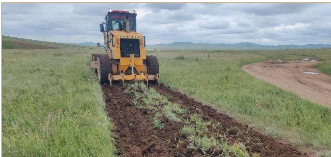
Зураг 51. Автогрейдер техникээр замын хөрс сийрэгжүүлэлт хийж буй байдал
