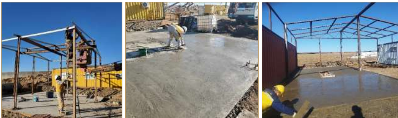
Зураг 24. Шинээр байгуулж буй засварын байрнуудын бетондсон шалны хэсэг
