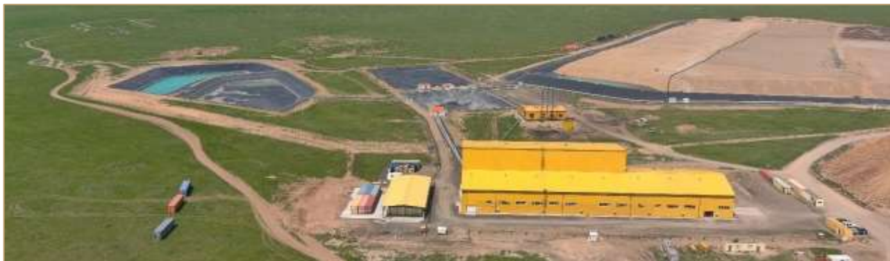
Зураг 10. Баяжуулах үйлдвэрийн барилга
