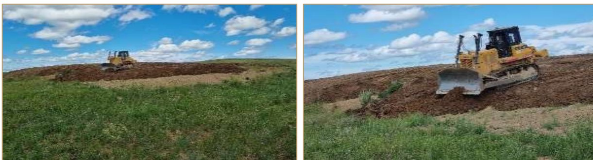
Зураг 58. Хаягдал материалын овоолгыг 12-14 градус болгон налуулж буй байдал
