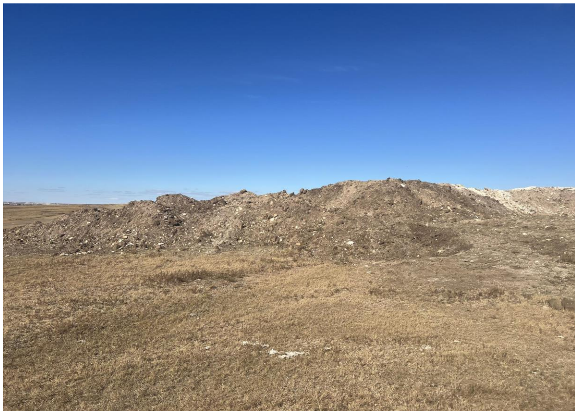
Зураг 8. Өнгөн хөрсийг хуулж овоолго байдлаар хадгалсан байдал
