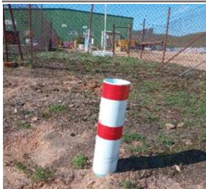
Хязгаарлалтын шонг будаж тодруулж, гэрэл ойлгогч шинэчлэн наасан байдал
