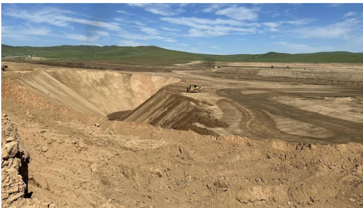
|Гадаад овоолгыг зөөж нөхөн дүүргэлт хийж буй явц
