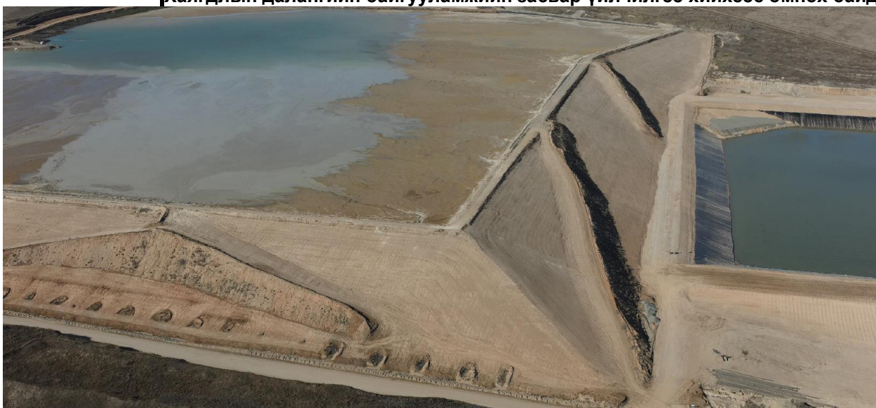
Хаягдлын далангийн байгууламжийн засвар үйлчилгээ хийсэн байдал
