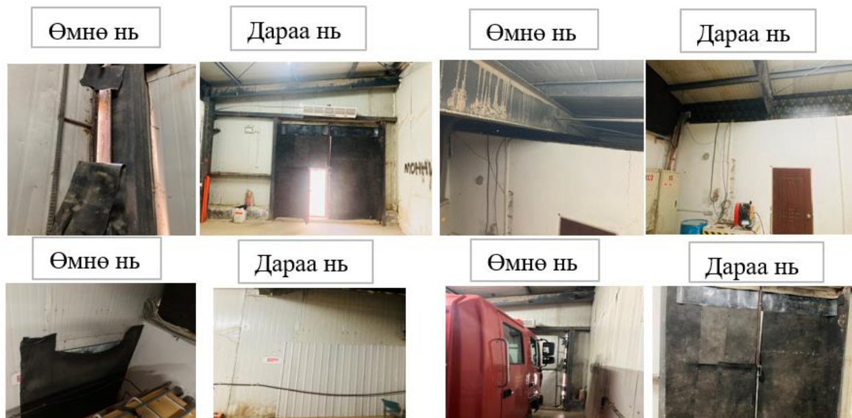
Аврах багийн байрны засвар үйлчилгээний ажил гүйцэтгэсэн байдал
