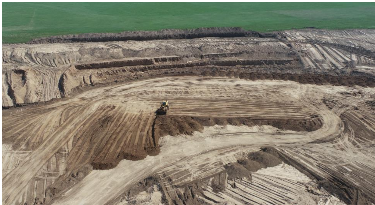
Нөхөн дүүргэлт хийж буй байдал
