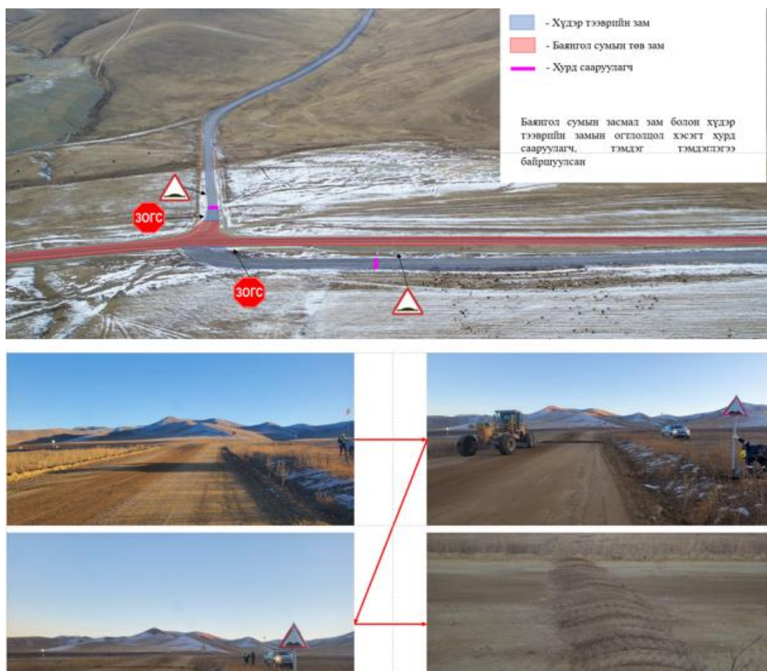
Хүдэр тээврийн зам төв замтай огтлолцох хэсэгт хурд сааруулагчийн өндөрлөж, шаардлагатай тэмдэг тэмдэглэгээ байрлуулсан
