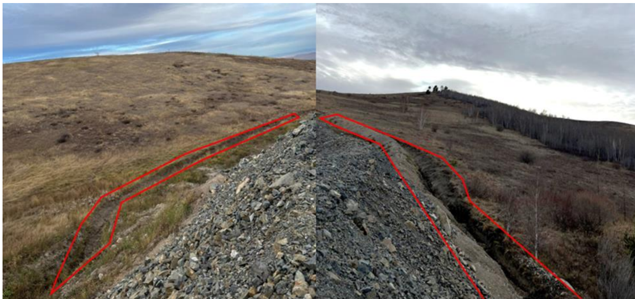
| Үерийн уснаас хамгаалах сувгууд байгуулсан байдал
