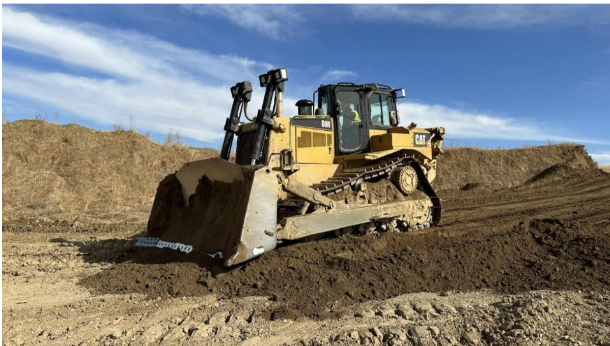
Их Дашир Үндсэн Хөндий адаг талбайг шимт хөрсөөр хучиж буй байдал
