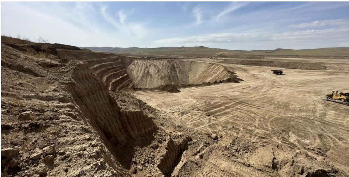
|2023.05.01-ны байдлаар нөхөн дүүргэлтийн ажил хийж байгаа байдал
