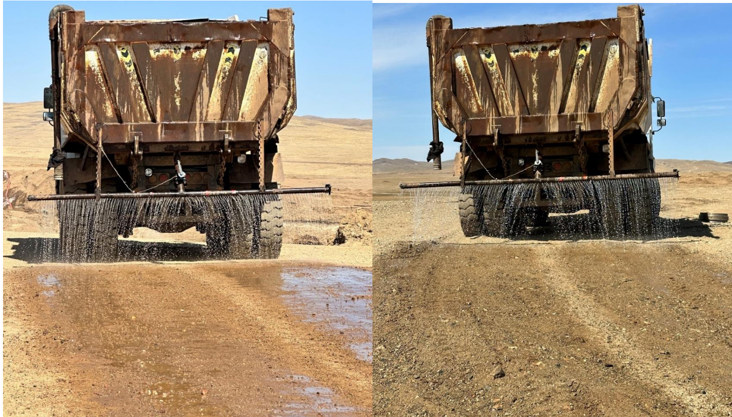
Зураг 7. Усалгаа хийж буй байдал
