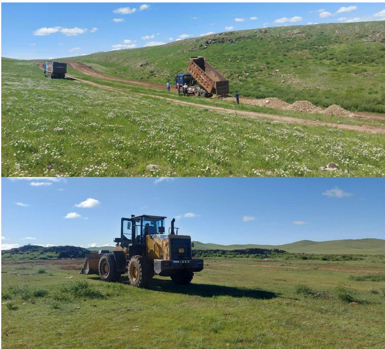
Зураг 5. Нөхөн сэргээлт хийж буй байдал
