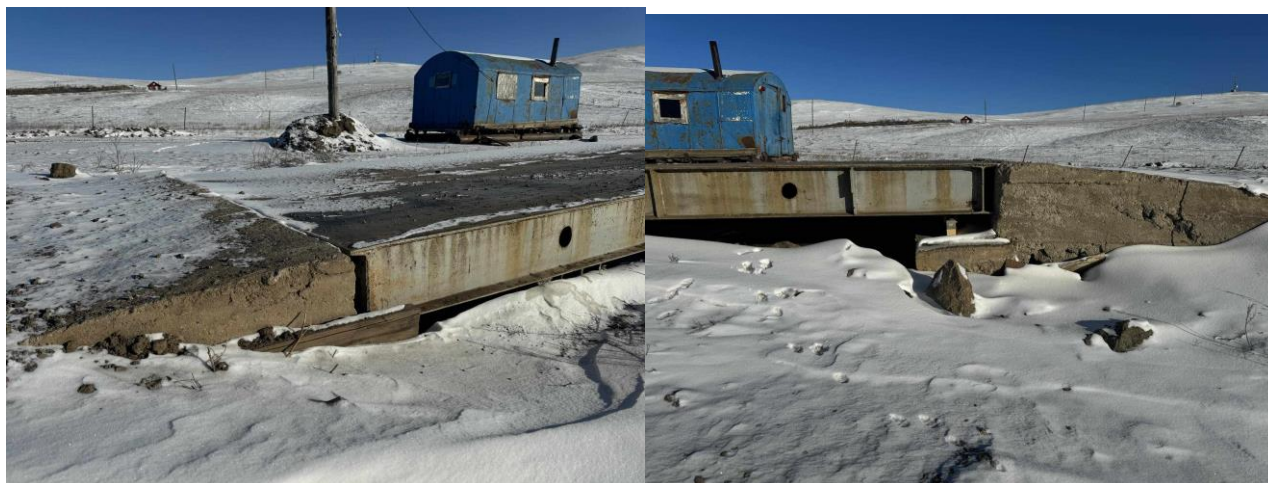
Зураг 2. Авто пүүний 2 талыг цементлэсэн байдал Ажилчдын байрны лагерын талбайн гэрэлтүүлгийг лед гэрлээр сольсон.
