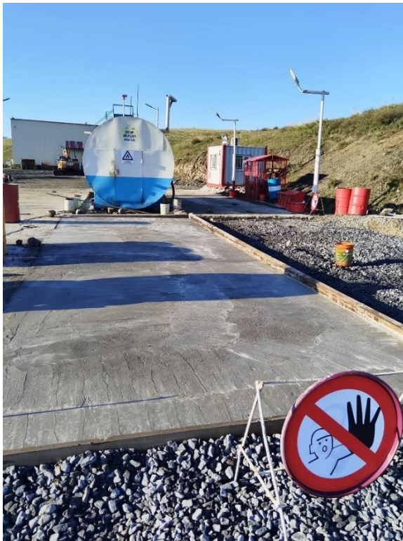
Зураг 9 ШТС-н орчмыг бетонжуулж буй байдал
