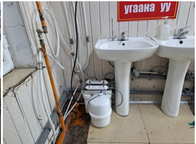
Зураг 8 Ус цэвэршүүлэх төхөөрөмж суурилуулсан байдал
