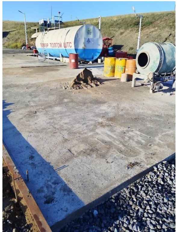
Зураг 9 ШТС-н орчмыг бетонжуулж буй байдал
