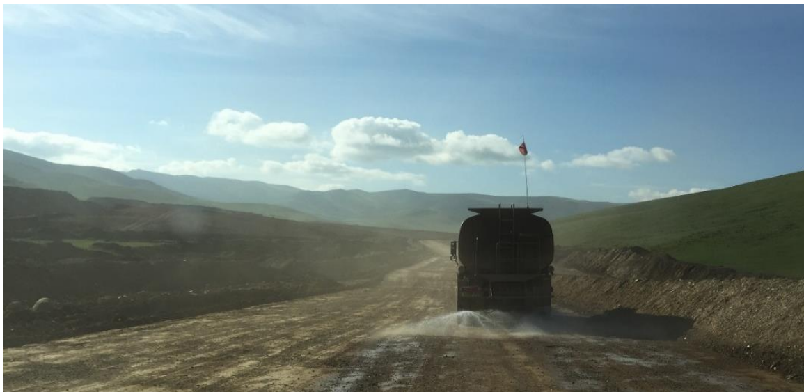
Зураг 8 Усалгааны ажил хийгдэж буй байдал
