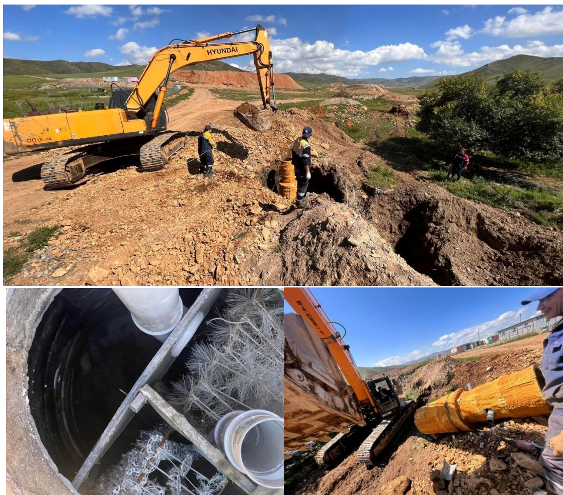
Зураг 38 Ахуйн шингэн хаягдал боловсруулах танк суурьлуулалтын ажил
