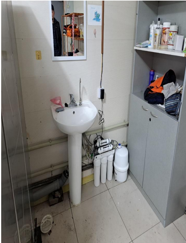
Зураг 15 Ус цэвэршүүлэх төхөөрөмж суурилуулсан байдал
