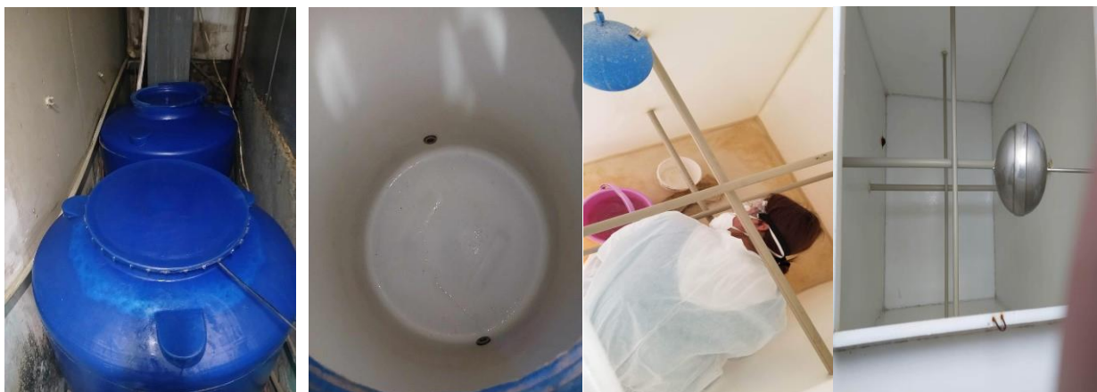
Зураг 10 Усны нөөцийн савнуудыг угааж ариутгаж буй байдал
