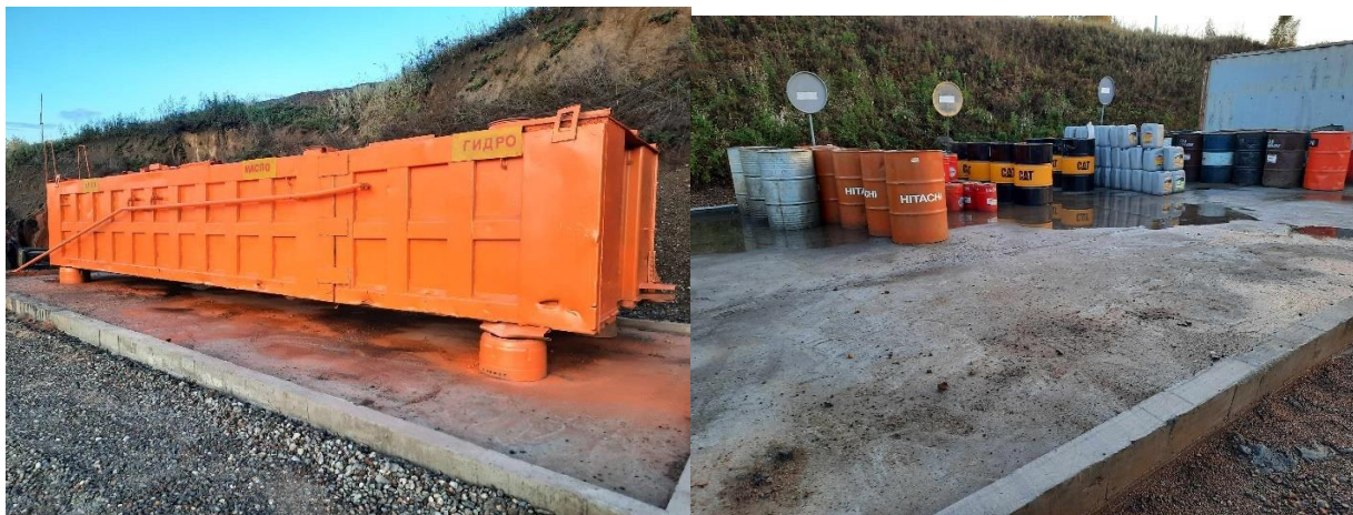
Зураг 17 Хаягдал болон шинэ тос хадгалах сав бетонжуулсан байдал
