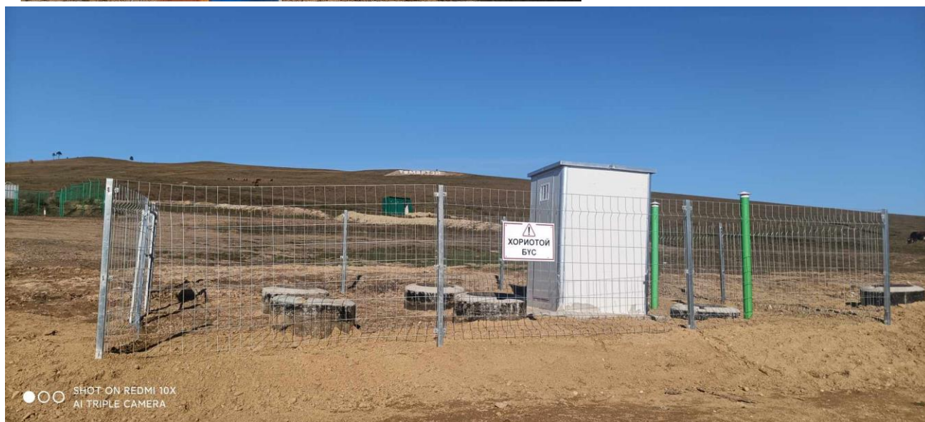
Зураг 20 Кемпийн орчимд хоногт 250 хүний хүчин чадалтай цэвэрлэх байгууламжийг суурилуулж буй байдал
