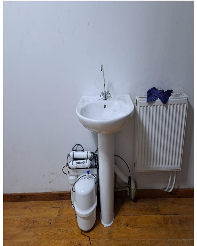
Зураг 15 Ус цэвэршүүлэх төхөөрөмж суурилуулсан байдал
